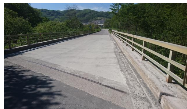
写真-4 供用後の宗山川3号橋
