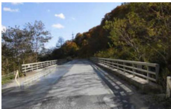
写真-1 宗山川3号橋の概観
