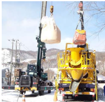
写真-3 移動式ミキサと組み合わせた現場でのコンクリート製造
