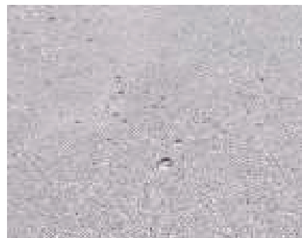
写真-7 床版面の細孔
