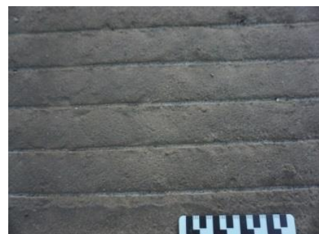
写真-4 横グルーピング仕上げの様子
