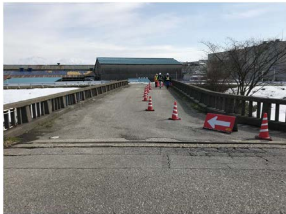
写真-3 興人橋の全景
