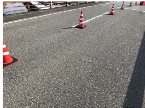
写真-1 針原橋の路面状況
