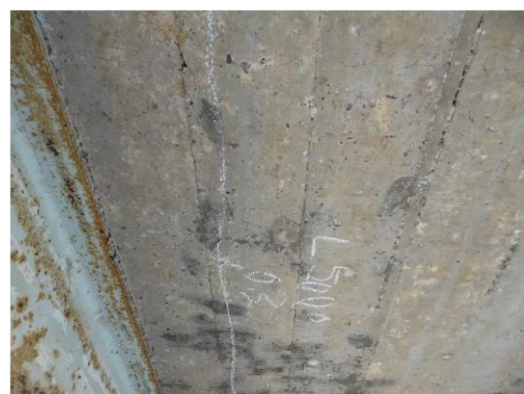
写真-2 農道橋の床板下面の状態
