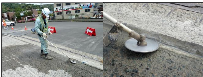
写真-6 既設コンクリートの下処理
