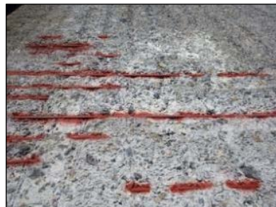
写真-4 WJ 後の床版面
