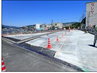
写真-12 床版補修完了
