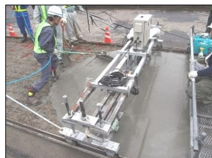
写真-9 敷均し機施工
