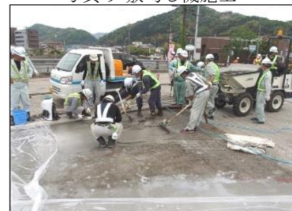
写真-10 人力による施工
