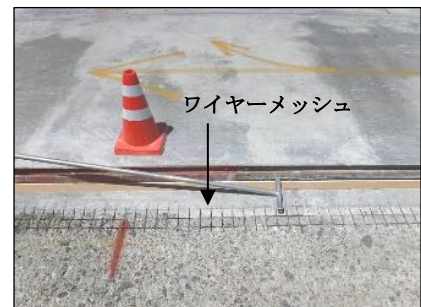
写真-7 打ち継ぎ部処理
