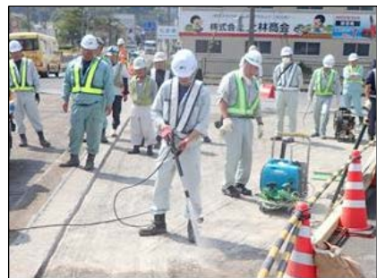
写真-8 散水状況
