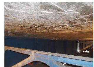
写真-2 床版下面の状況
