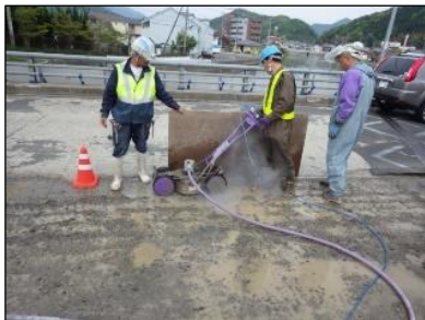
写真-3 WJ 作業状況
