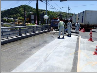
写真-14 プライマー塗布
