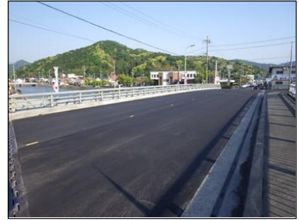
写真-16 舗装工完了
