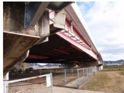
写真-3 橋梁の現況
