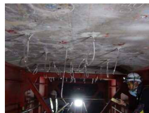
写真-12 充填材注入作業の状況
