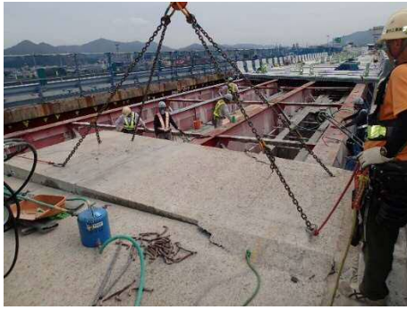
写真-13 RC床版の撤去状況
