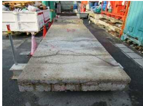
写真-14 切断・撤去したRC床版
