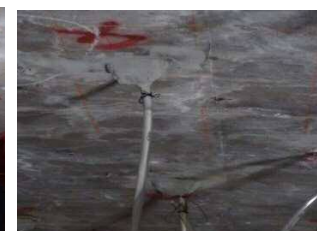
写真-12 充填材注入作業の状況
