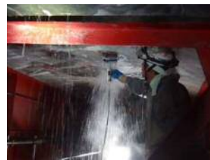
写真-7 洗浄作業の状況
