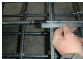
図-5 ゲージ設置状況
