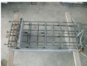
図-4 配筋状況 (主筋)
