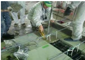
図-6 継手部 Co 打設
