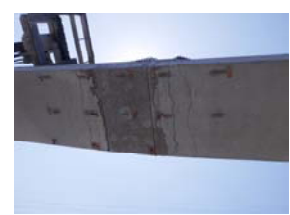
図-21 2点曲げ試験破壊状況 （継手あり）
