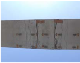
図-24 1点曲げ試験破壊状況 (継手あり)
