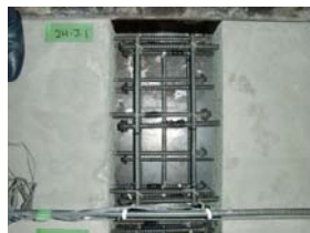
図-7 ひずみゲージ設置状況
