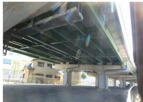
写真-1 富野高架橋 (P10~P11)
