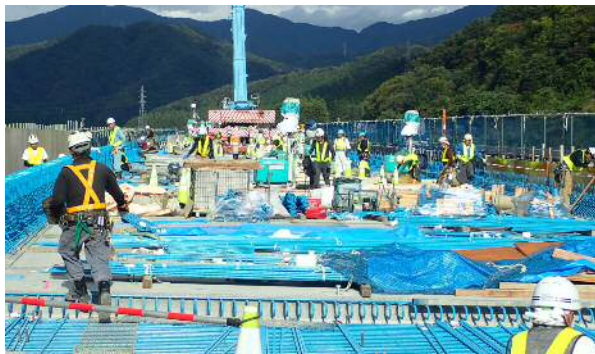
写真-1 錯綜する橋面作業状況
