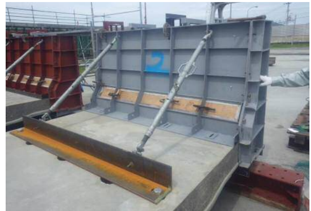
(壁高欄型枠設置状況)
