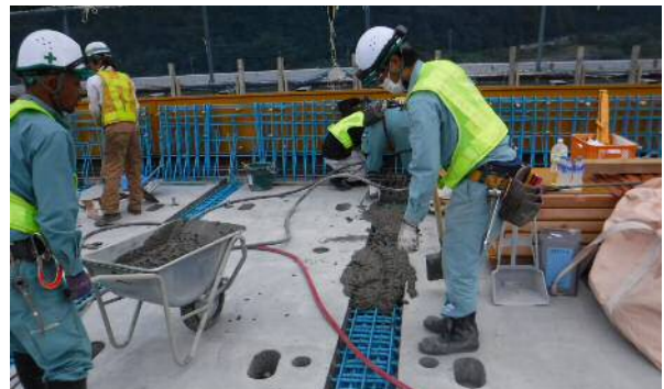
写真-2 床版間詰部の施工（コンクリート打設）
