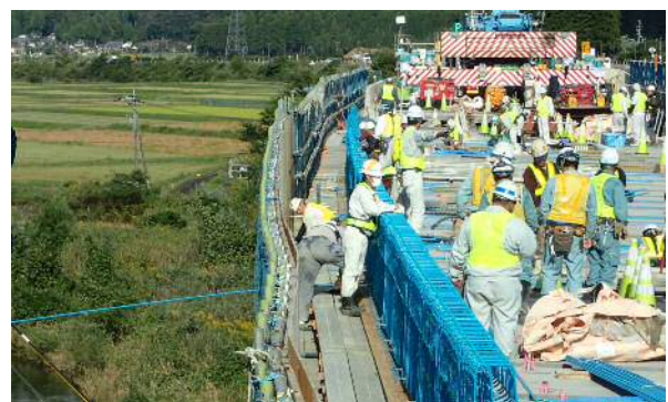
写真-3 床版間詰部の施工（側面からの鉄筋挿入）
