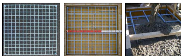
(1) MG の配置 (2) コンクリート打設 写真-3 MGC 床版供試体の製作工程
