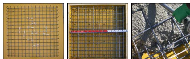
(1) 鉄筋組上げ (2) コンクリート打設 写真-2 RC 床版供試体の製作工程
