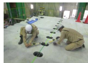
●床版連結（ボルト締付）
