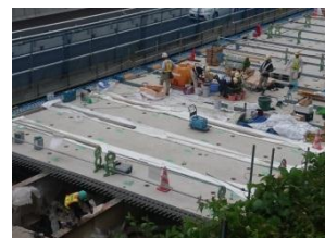
STEP10: 湿潤養生 (シート)
