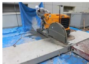
写真-4 床版切断状況 (1分/m)
