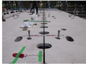
STEP4: 架設完了
