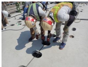
STEP5: 仮締め (電動レンチ)
