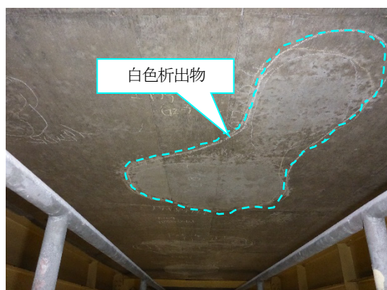
写真-2 床版の状況
