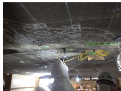
写真-8 TW センサー設置
