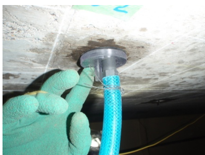
写真-5 パッキン取り付け
