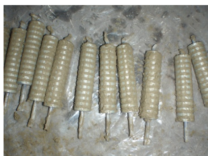
写真-4 ベントナイトの取り付け
