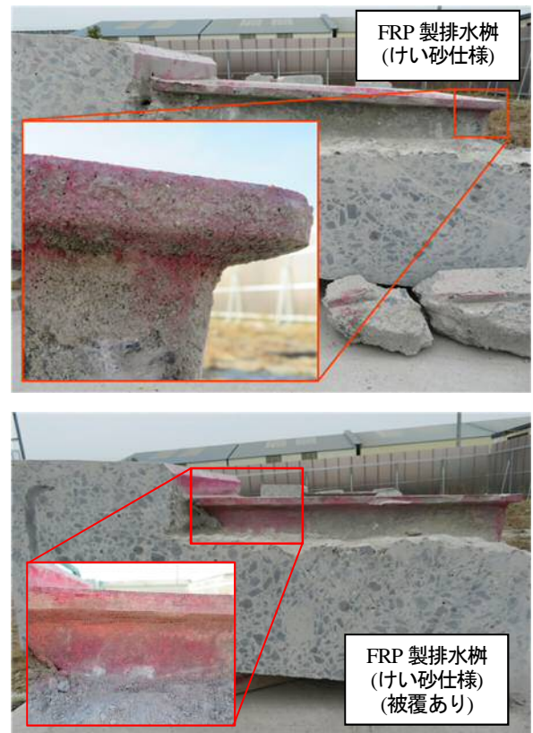
図-10 FRP 製(けい砂仕様)排水樹の状況
