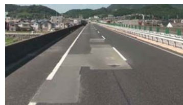
写真-1 床版取替え前の橋面状況
