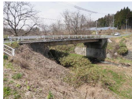
図-4 既設橋外観
