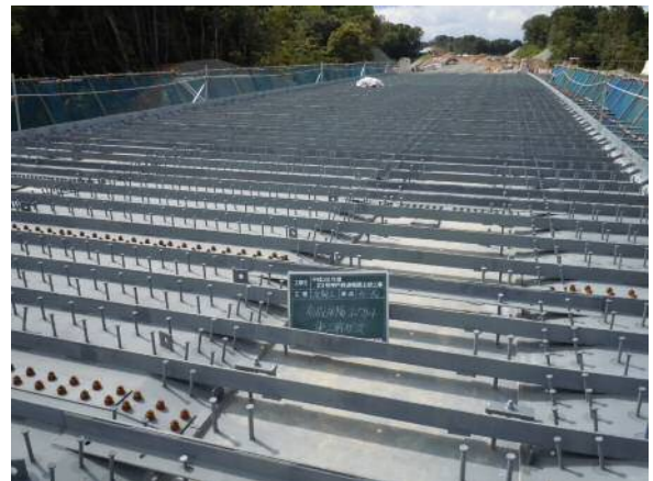
図-12 合成床版の底鋼板の例
