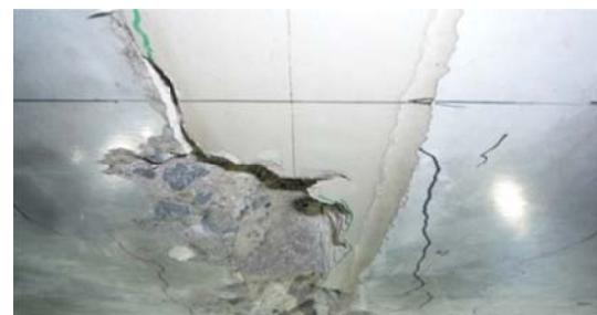
図-4 継手 No.1 破壊状況
