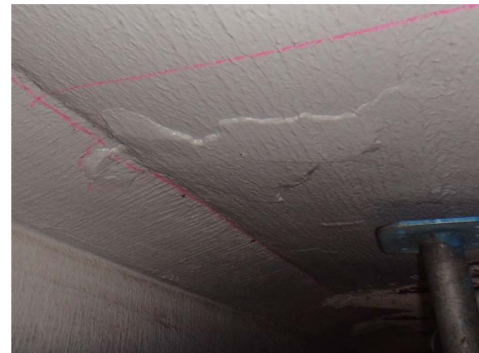
浮きが疑われる凹凸が生じている箇所
