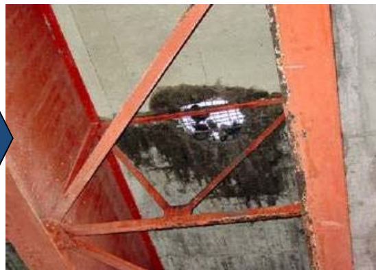
床版コンクリートの抜け落ち
