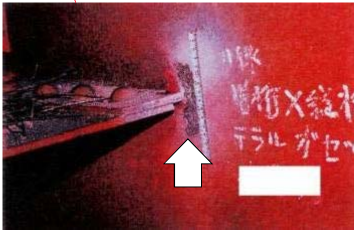
主桁ウェブと面外ガセットの継手部
