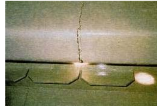
例：鋼床版縦リブの継手部
