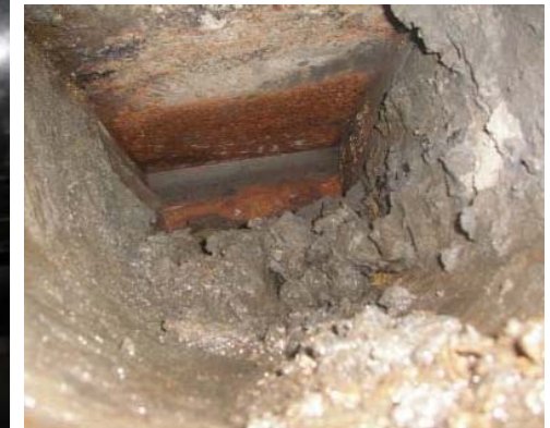
縦リブ内の堆積物 (デッキ貫通き裂部からの浸入。)
