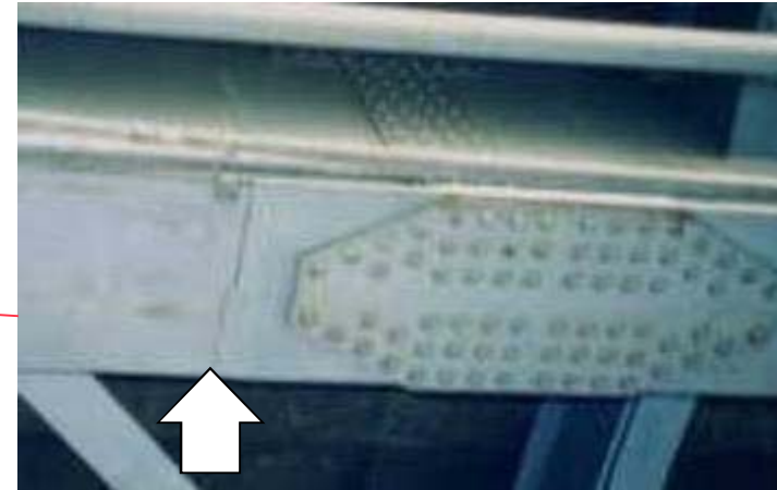
主桁下フランジの継手部
