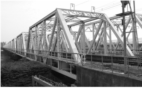
図-10 対象橋梁外観
