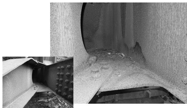
図-4 ガセット部の塵埃堆積
