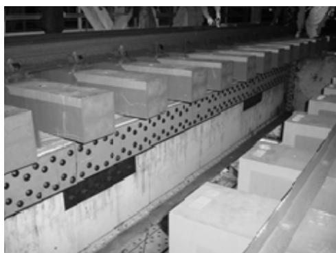
(c) 縦桁上フランジ交換（交換後）
