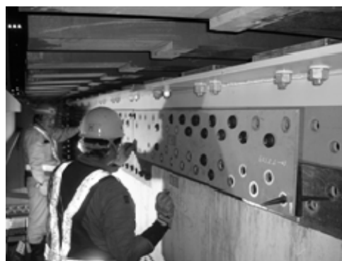
(b) 縦桁上フランジ交換（施工中）
