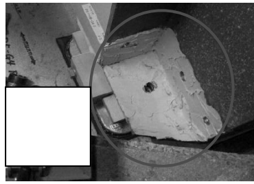
(b)エポキシ樹脂施工後
