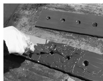
図-17 接着剤塗布状況
