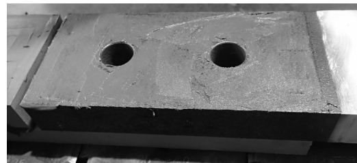
(d)金属パテ施工後
