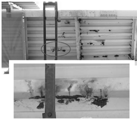
Uリブ凸部で合わせた構造
