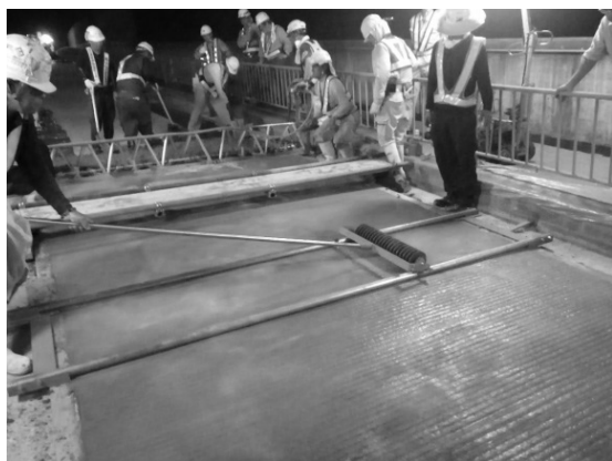
写真-5.3.9 仕上げ状況
