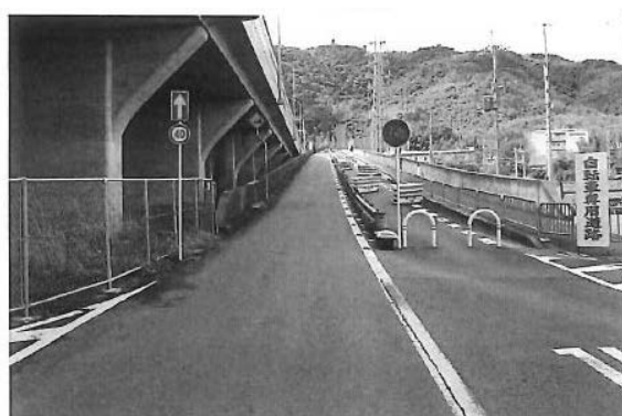
写真-5.1.1 施工前の天王山古戦橋
