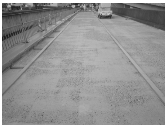
写真-5.3.1 ショットブラスト完了 遠景
