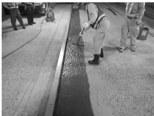
写真-5.3.3 接着剤塗布 (端部)
