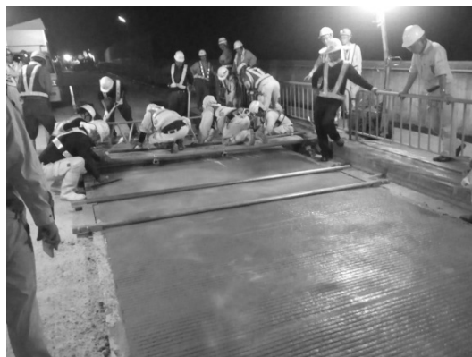
写真-5.3.8 コテ仕上げの状況
