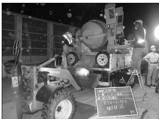
写真-5.3.5 ポットミキサでの製造
