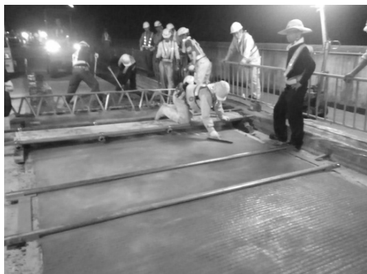
写真-5.3.7 敷きならしの状況
