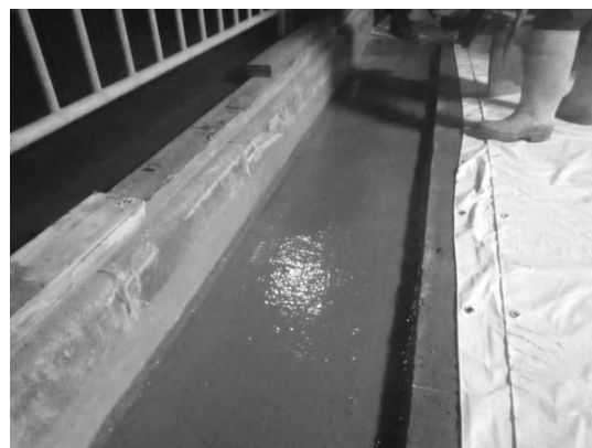
写真-5.3.4 接着剤塗布 (地覆部)
