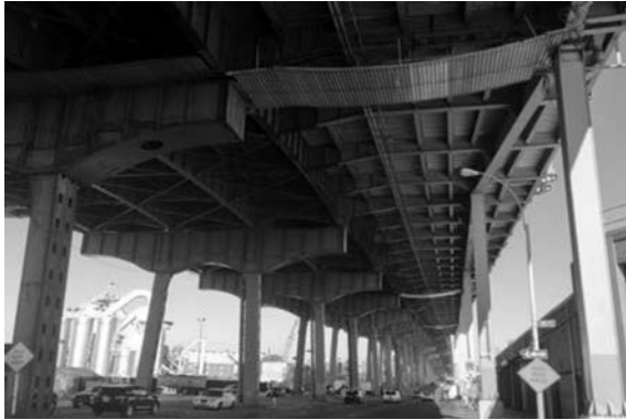
写真-3.3.3 278号線高架橋と鋼製残存型枠
