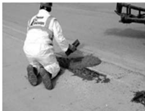
写真-3.1.1 PPCによるパッチング (出典 CALTRANS)
