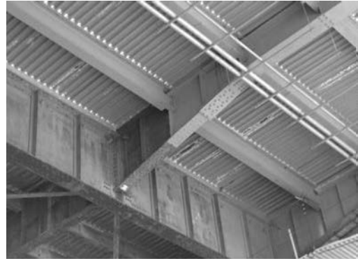
写真-3.3.3 278号線高架橋と鋼製残存型枠
