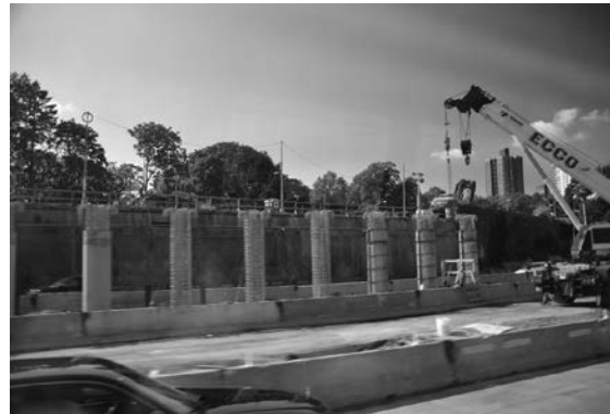
写真-3.4.1 橋梁架替中の下部工施工現場
