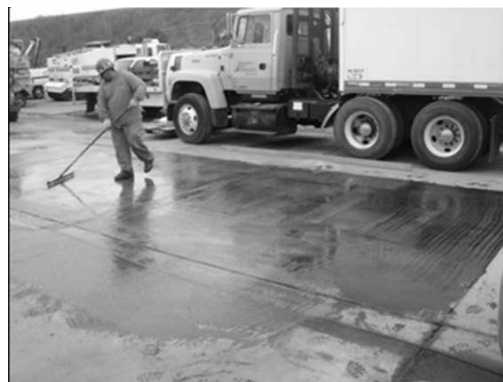
写真-3.1.2 Methacrylateの塗布 (出典 CALTRANS)
