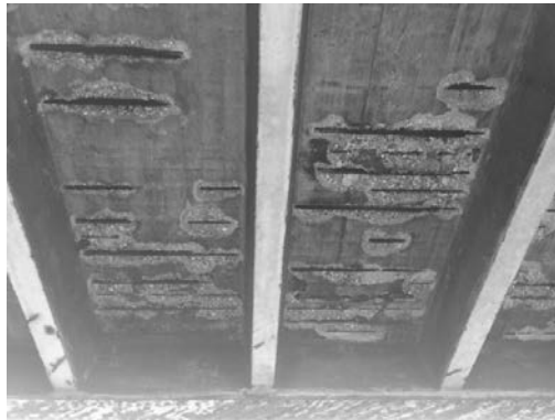
写真-3.3.4 道路交差点の道路橋のRC床版
