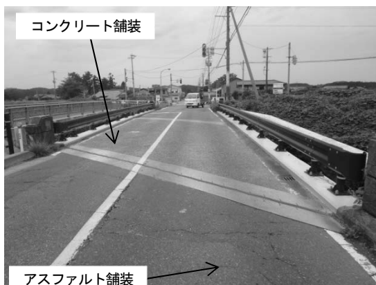
写真-2.1.14 双川橋の橋面 (2014.8)
