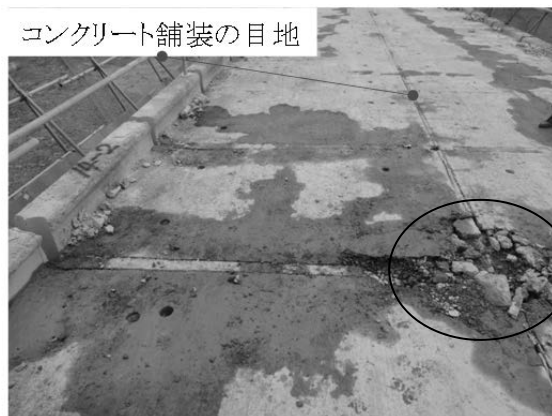
写真-2.3.5 目地部の損傷
