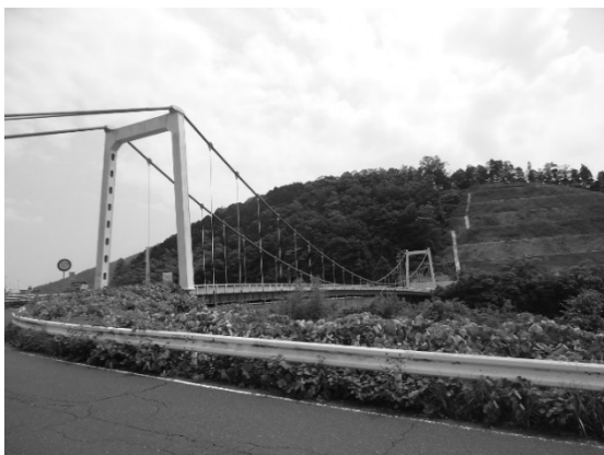
写真-2.1.1 八雲橋の全景(2014.6)
