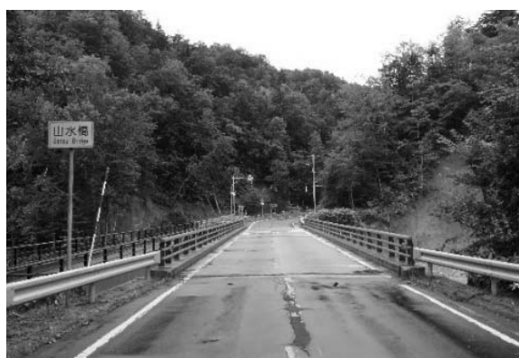
写真-2.2.1 山水橋の全景（起点側）
