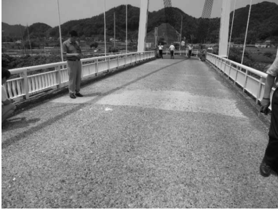
写真-2.1.3 八雲橋の修繕箇所1(2014.6)
