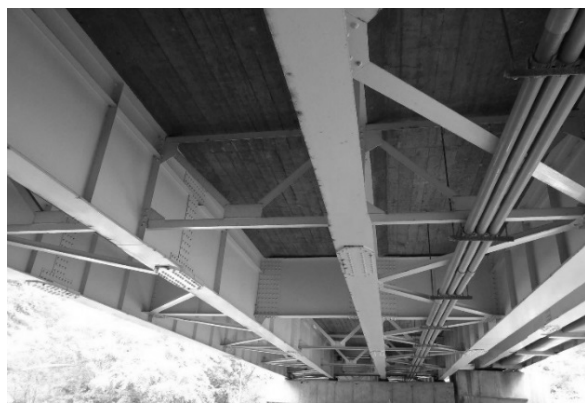
写真-2.2.17 群別橋の床版下面状況（起点側）
