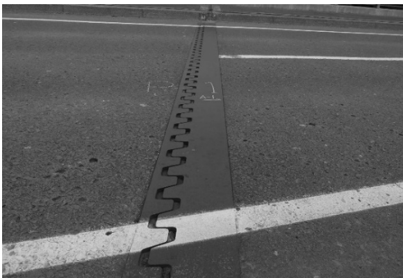
写真-2.2.15 群別橋の路面状況（起点側）
