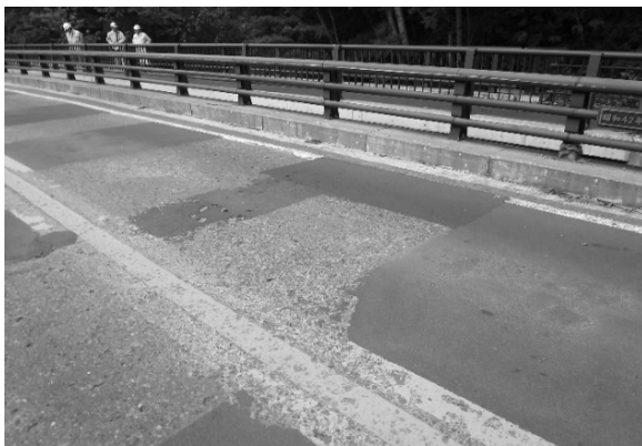
写真-2.2.9 湖水橋の路面状況（起点側）
