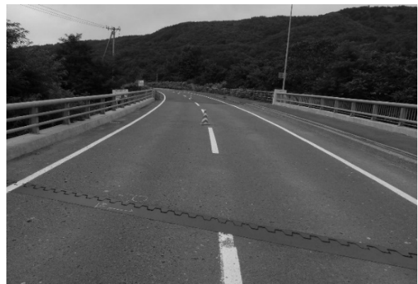
写真-2.2.16 群別橋の路面状況（終点側）
