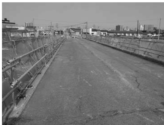
写真-2.3.2 九年橋の2主鈹桁のアスファルト舗装の状況
