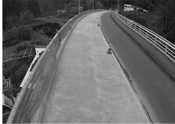
写真-2.4.4 橋面コンクリート舗装の仕上がり状況
