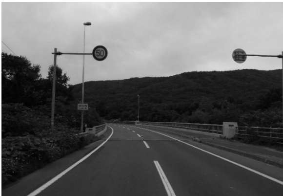
写真-2.2.13 群別橋の全景（起点側）
