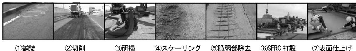
図-2.6.2 SFRC 上面増厚工法
