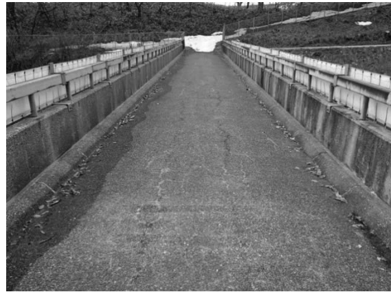
写真-2.5.2 人母跨道橋の路面状況
