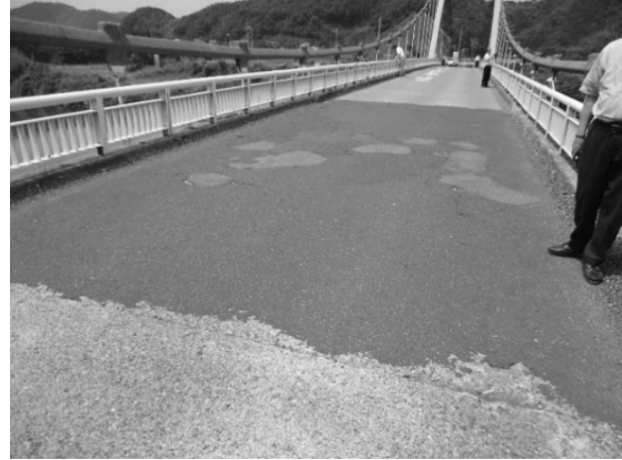
写真-2.1.4 八雲橋の修繕箇所2(2014.6)
