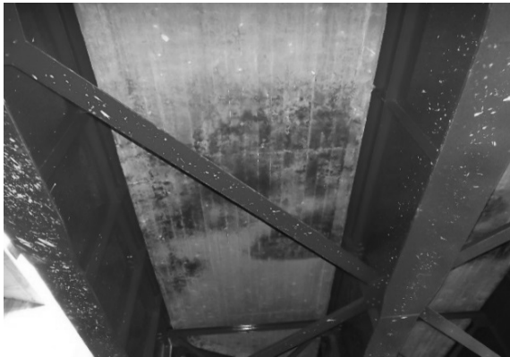
写真-2.2.11 湖水橋の床版下面状況（起点側）
