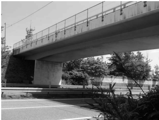
写真-2.5.3 山口釜屋跨道橋の全景
