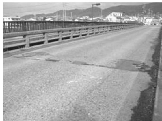
写真-2.1.6 依田川橋の路面の状況(2007.9)
