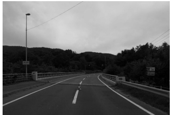
写真-2.2.14 群別橋の全景（終点側）
