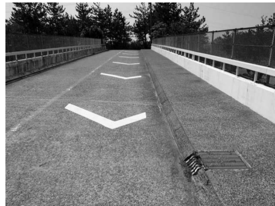
写真-2.5.4 山口釜屋跨道橋の路面状況
