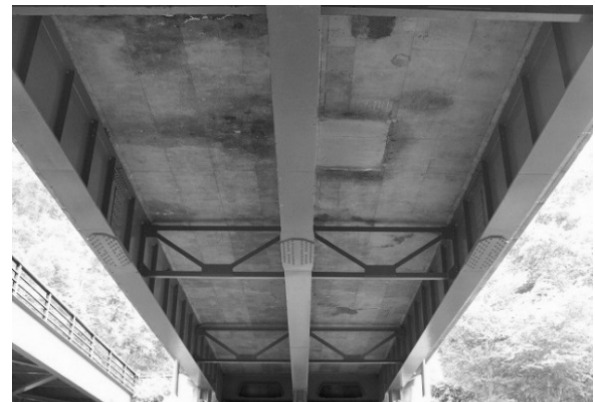
写真-2.2.6 山水橋の床版下面状況（終点側）
