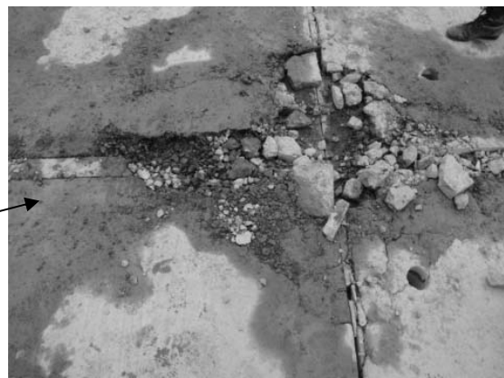
写真-2.3.5 目地部の損傷
