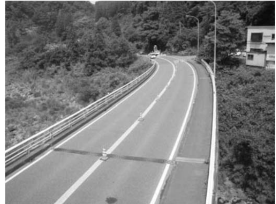
写真-2.4.2 湯山橋の路面状況
