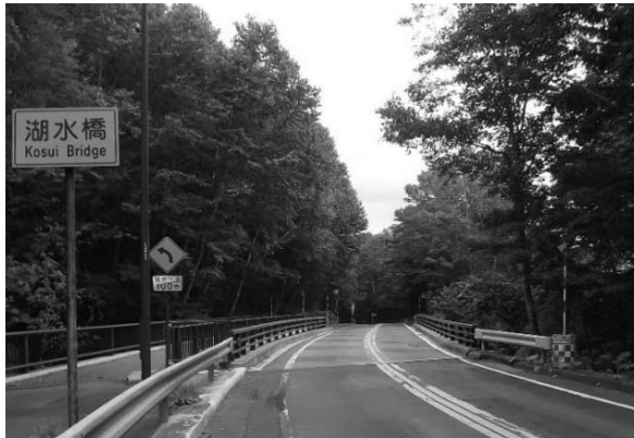
写真-2.2.7 湖水橋の全景（起点側）
