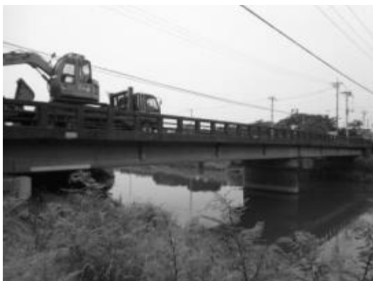
写真-2.1.10 上船渡橋の側面状況
