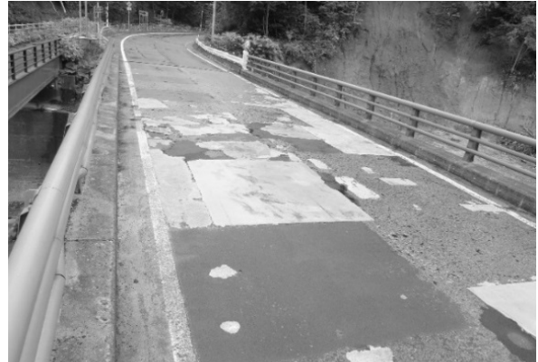
写真-2.2.4 山水橋の路面状況（終点側）
