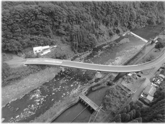
写真-2.4.1 湯山橋全景
