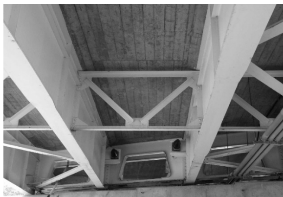
写真-2.2.18 群別橋の床版下面状況（終点側）
