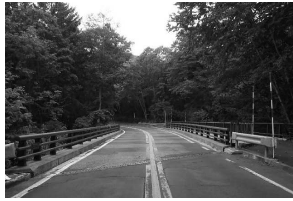
写真-2.2.8 湖水橋の全景（終点側）
