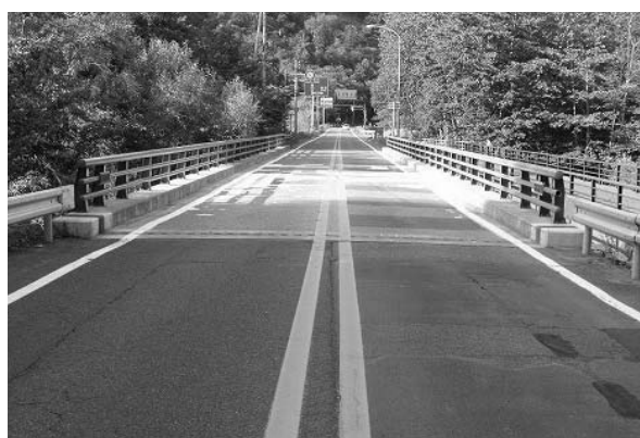
写真-2.2.2 山水橋の全景（終点側）
