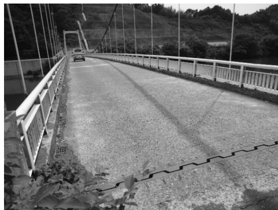
写真-2.1.2 八雲橋の路面の状況(2014.6)
