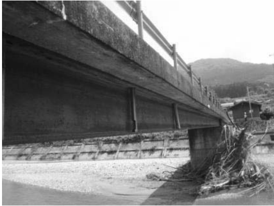
写真-2.1.12 大蔭橋の側面状況 (2014.6)
