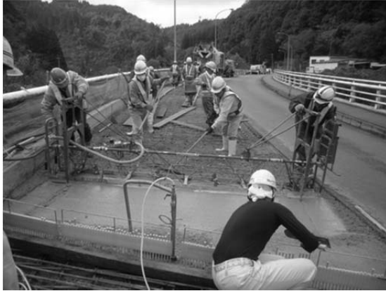
写真-2.4.3 橋面コンクリート舗装の施工状況
