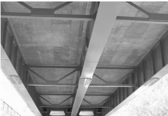
写真-2.2.5 山水橋の床版下面状況（起点側）
