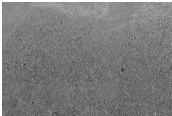
写真-2.1.8 栄橋のSFRC舗装上面
