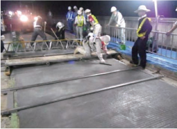
LMC 打設直後の表面仕上げ
