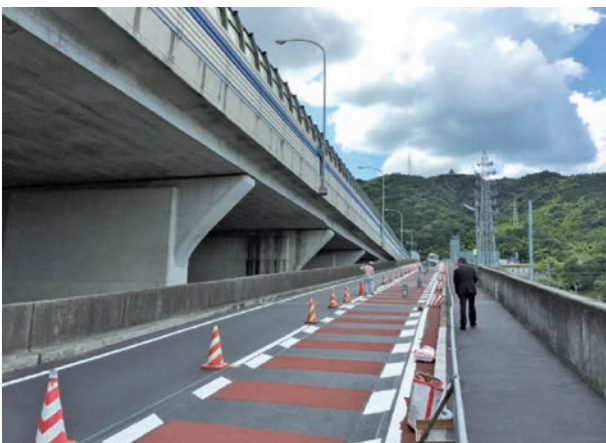
施工後の天王山古戦橋
