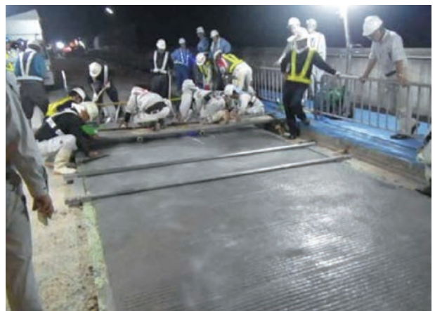
LMC の打設状況
