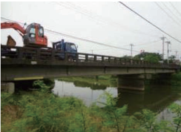
上船渡橋の側面写真 (2013.6)
