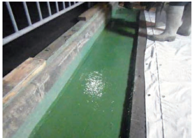
端部への接着剤塗布：歩道側
