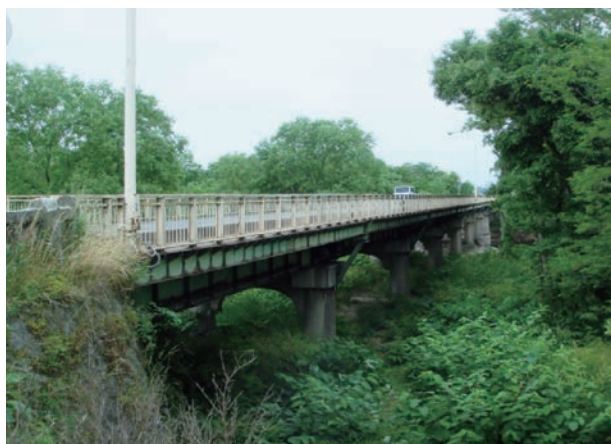
施工前の九年橋
