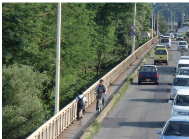
施工前の九年橋
