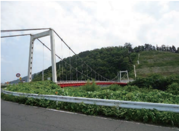
八雲橋の全景 (2014.6)
