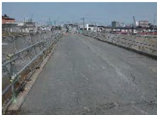
施工前の九年橋
