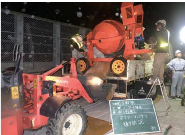
ラテックス改質コンクリート (LMC) の供給状況
