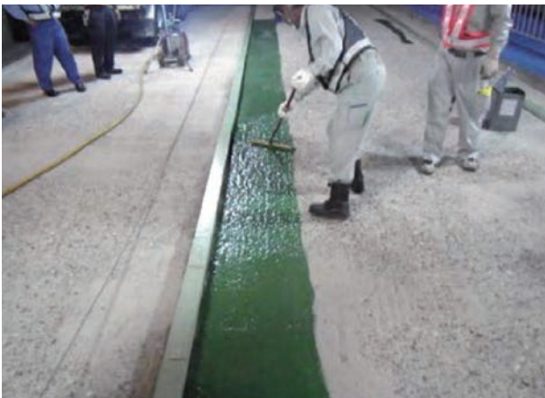
端部への接着剤塗布：車線中央部
