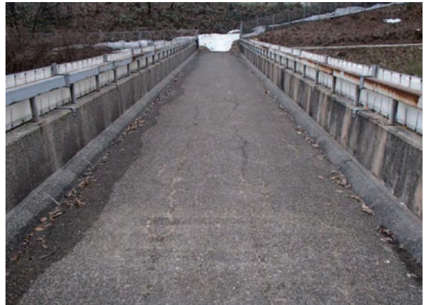
人母跨道路橋の路面状況
