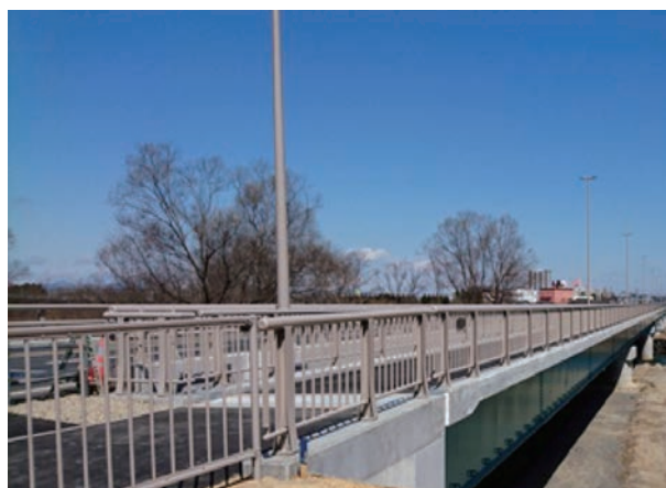
施工後の九年橋
