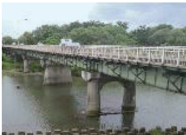
施工前の九年橋
