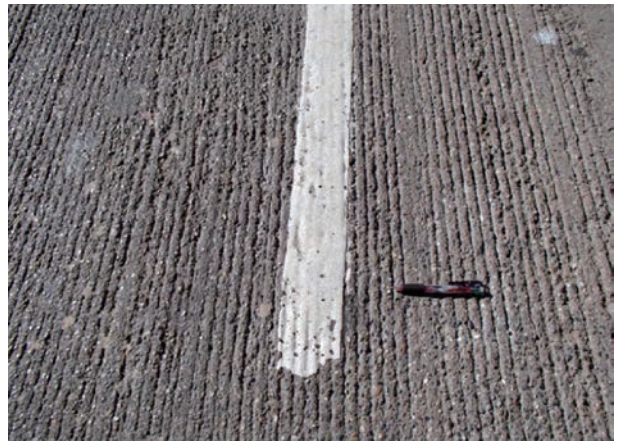
タイングルーピングされたコンクリート舗装
