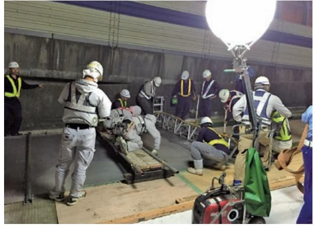
LMC 打設直後の表面仕上げ
