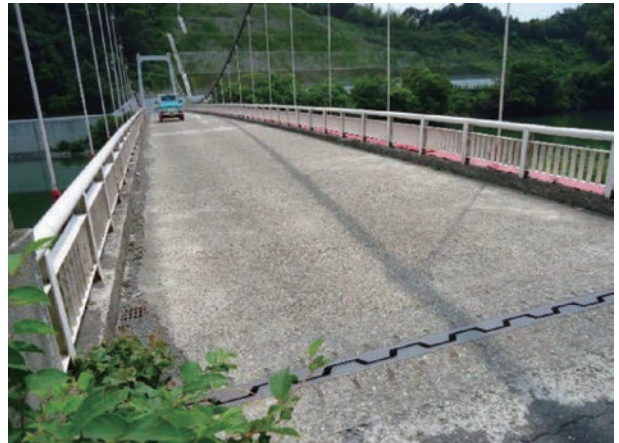
八雲橋の路面状況 (2014.6)
