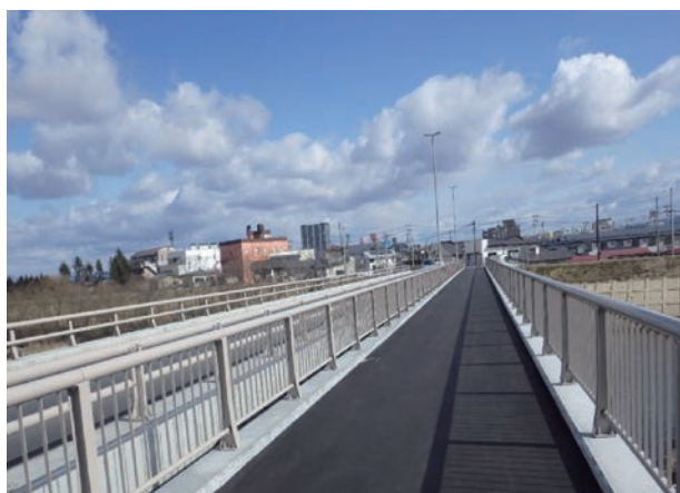
施工後の九年橋
