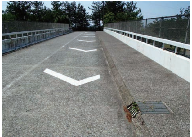
山口釜跨道路橋の路面状況
