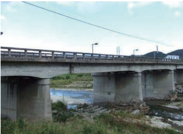
依田川橋の側面写真 (2007.9)
