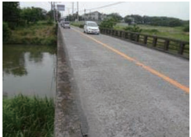
上船渡橋の橋面状況 (2013.6)
