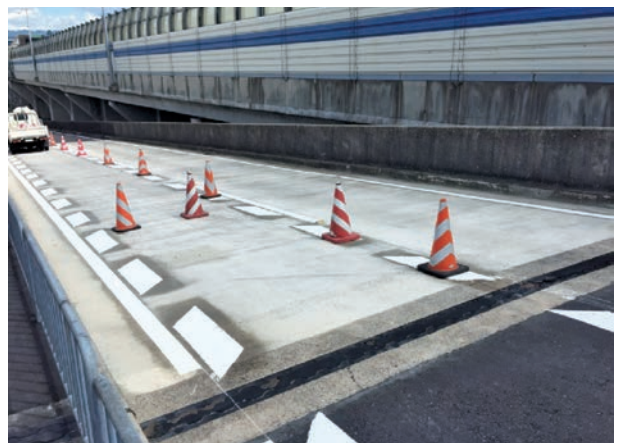
施工後の舗装面
