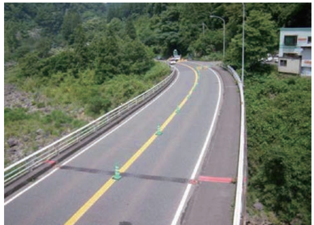
湯山橋の路面状況
