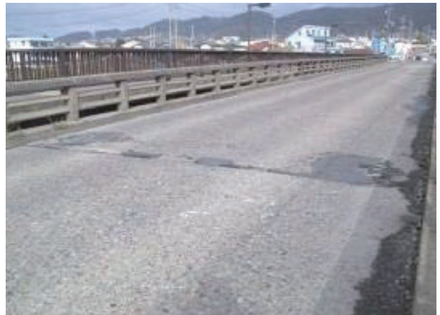
依田川橋の路面状況 (2007.9)
