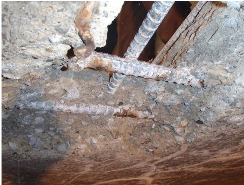
写真一床版の陥没状況
