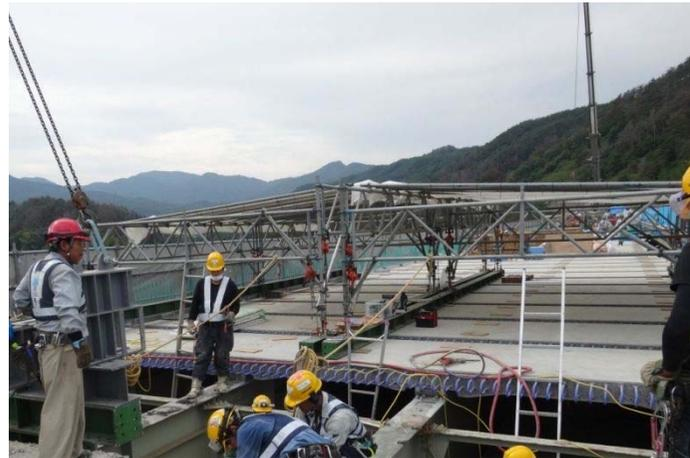
写真：仮屋根の施工例（出典：横河ブリッジ）
