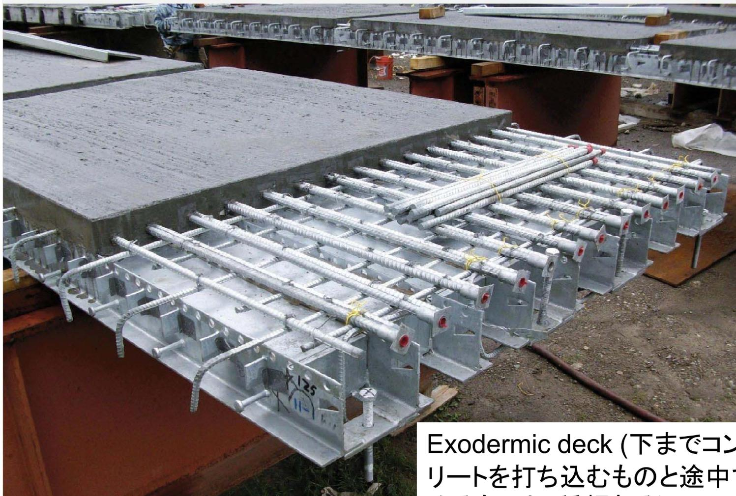
Exodermic deck (下までコンクリートを打ち込むものと途中で止めるものと2種類ある)
