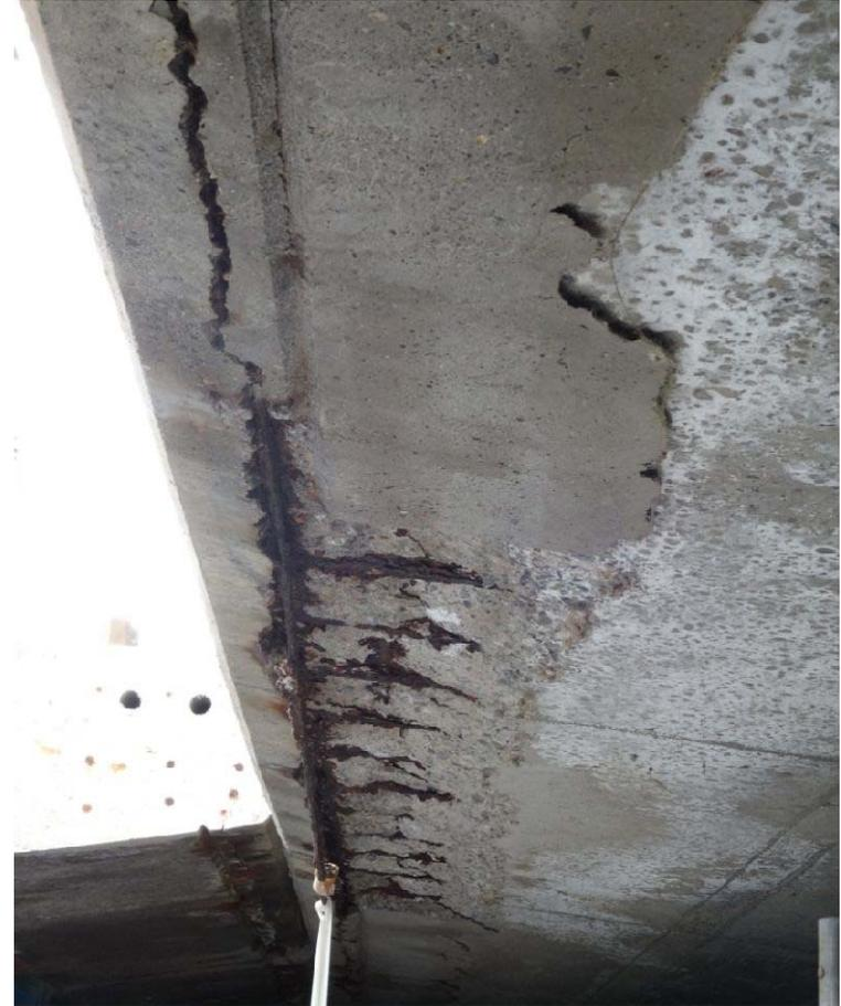
**写真 塩害による損傷例**
