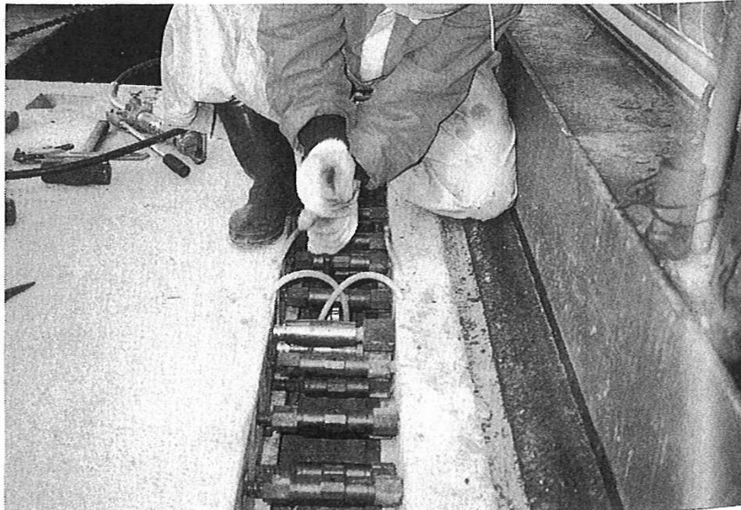
**写真：主鉄筋の機械式継手（名神松尾川橋の拡幅工事）**
