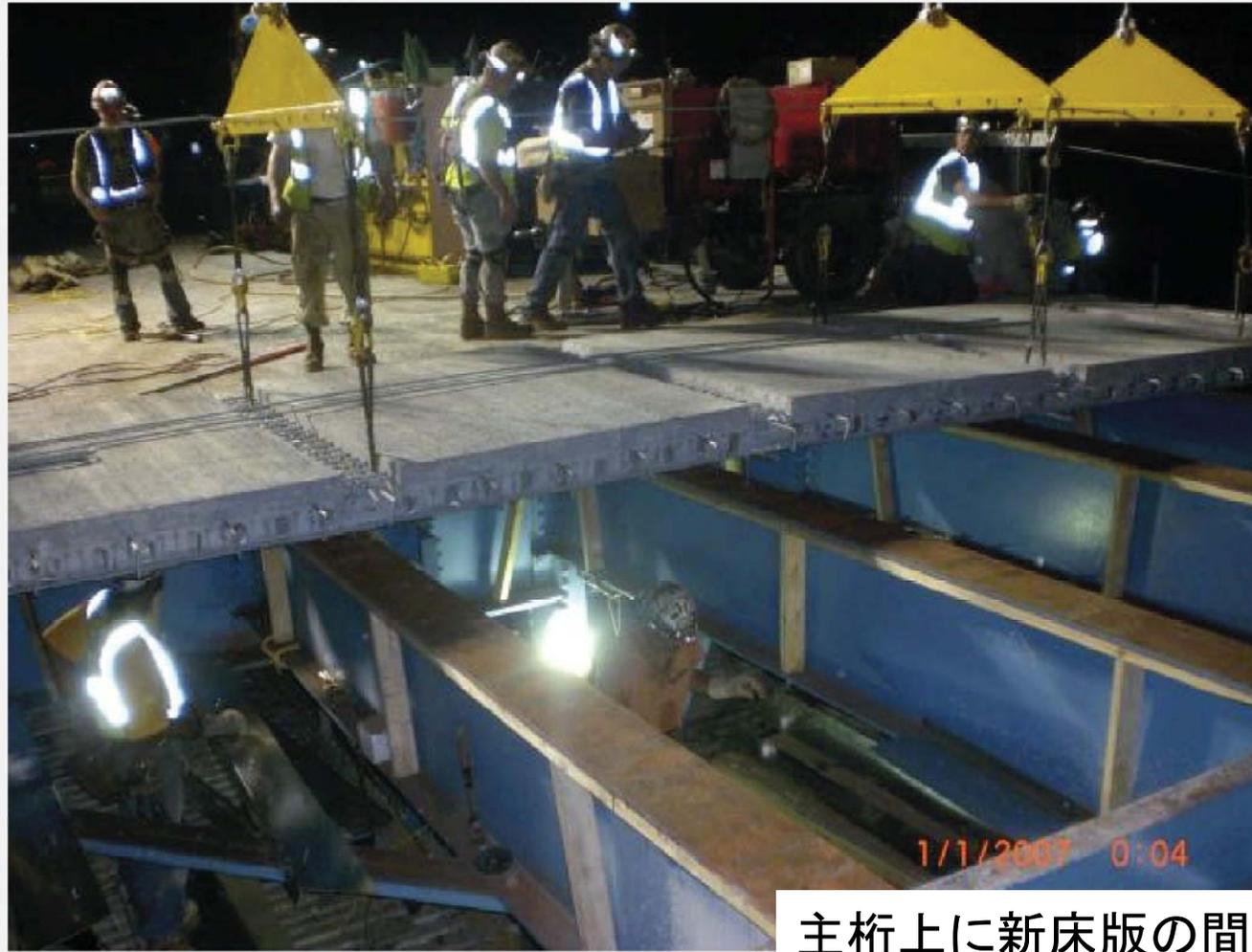
主桁上に新床版の間詰めを設けることで型枠の廃止につながる
