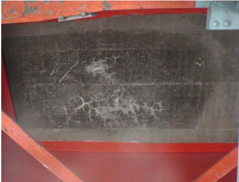
写真一床版下面からの損傷状況
