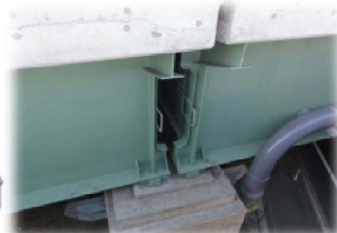
桁端マンホール設置例
