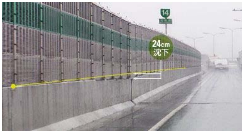
橋桁中央部の垂れ下がり
