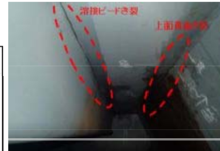
ビードき裂と貫通き裂(桁内)
