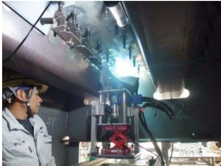
スタッドボルト溶接
