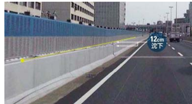
3径間にわたる橋桁の垂れ下がり発生
