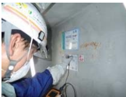
〔測定状況(超音波板厚計)〕
