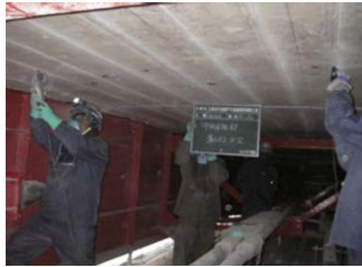
図-付 5. 2. 13 床版上面への電気防食適用例（米国） 図-付 5. 2. 14 床版下面への電気防食の適用例（日本）
