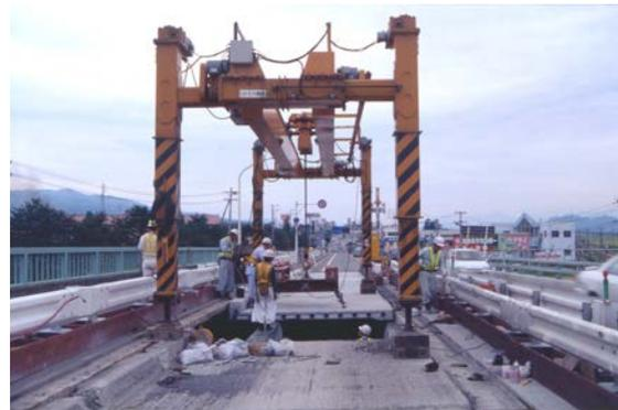
図-付 5. 2. 55 組立式クレーンによる取替床版の仮設
