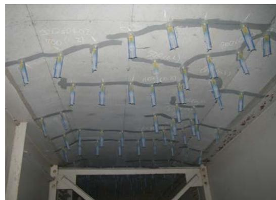
図-付 5.2.3 ひび割れ注入概念図と床版下面での注入工法
