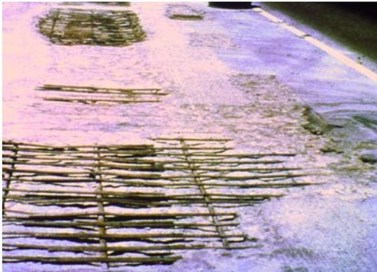
図-付 5. 2. 11 道路橋上面の塩害劣化損傷事例（米国）
