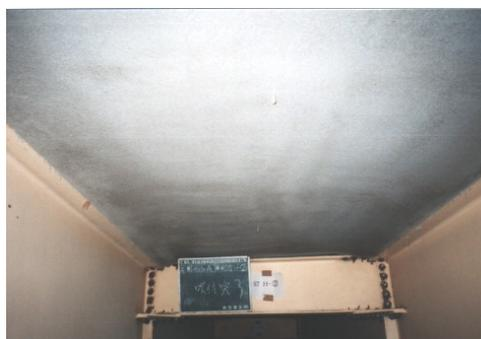
図-付 5. 2. 43 下面増厚補強完了
