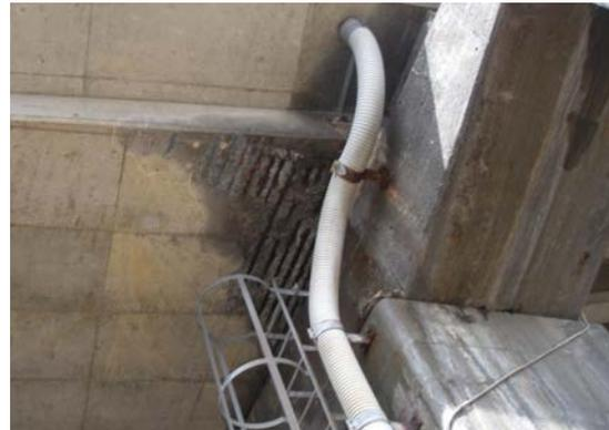
図-付 5. 2. 12 道路橋下面の塩害劣化損傷事例（日本）
