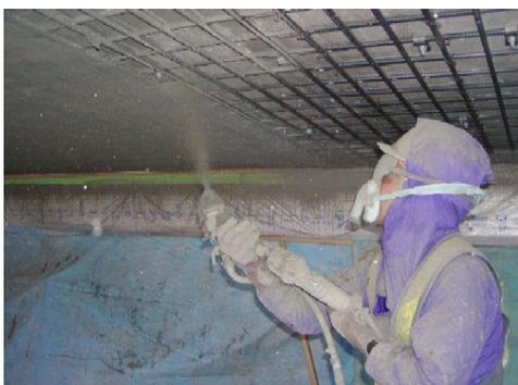
図-付 5. 2. 42 PCM 吹き付け状況
