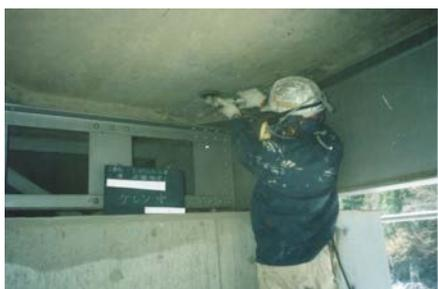
図-付 5. 2. 30 下地処理工
