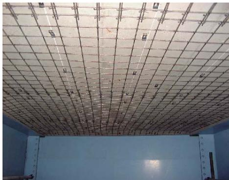
図-付 5. 2. 41 補強筋取付け状況
