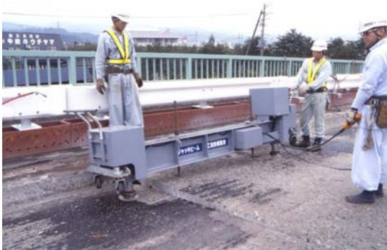
図-付 5. 2. 54 撤去床版の支持桁とはく離用機材
