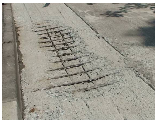
図-付 4.10.6 コンクリート劣化部の撤去状況
