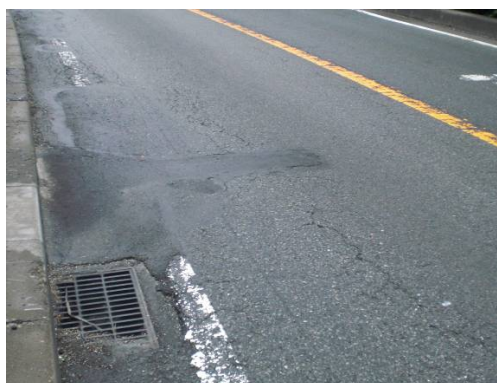
図-付 4.10.3 アスファルト舗装の状況
