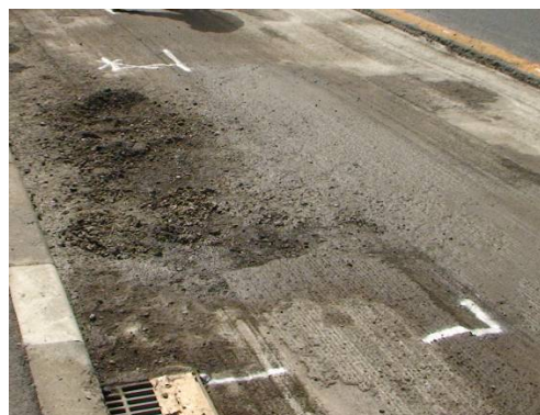
図-付 4.10.4 床版上面の状況（舗装開削）
