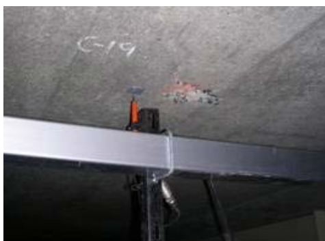
図-付 2.3.8 床版たわみの測定
