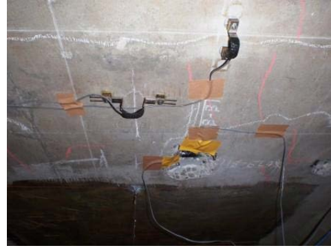
図-付 2.3.11 ひび割れ開口変位の測定
