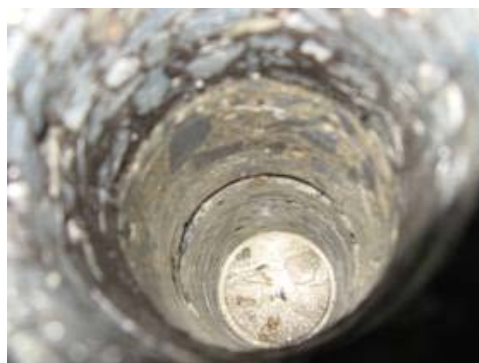
図-付 2.3.15 採取孔の目視調査
