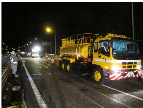
図-付 2.3.6 荷重車に載荷試験状況
