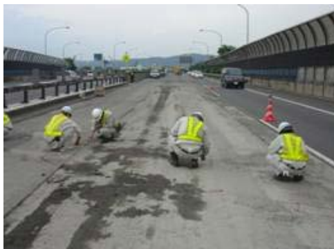
図-付 2.3.12 打音調査および目視調査
