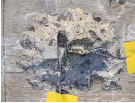
図-付 2.3.10 鉄筋ひずみの測定
