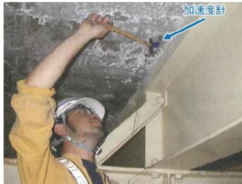
図-付 2. 3. 22 衝撃弾性波法による調査状況
