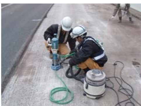
図-付 2.3.14 コアボーリング
