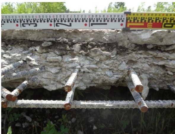
図-付 1.14 事例 2, 床版はつり面及び切断面で見られたコンクリートの砂利化
