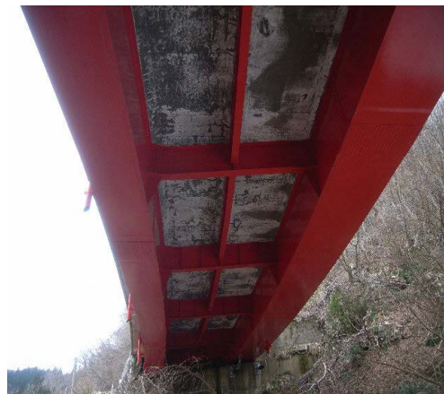
図-付 1.55 事例 10, 供用下の床版下面の状況
