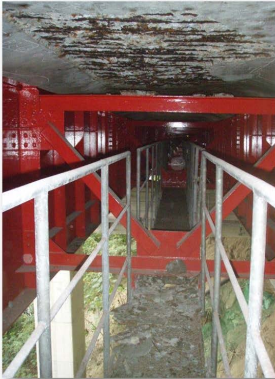
図-付 1.19 事例 4, 床版下面のかぶり不足と鉄筋腐食
