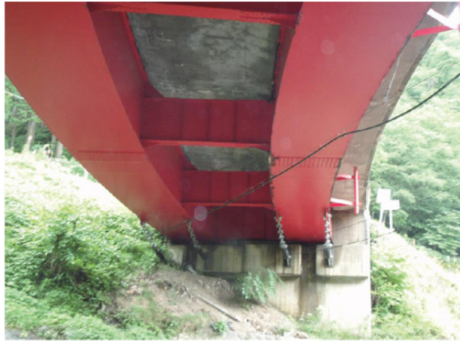
図-付 1.31 事例 6, 供用下の床版下面
