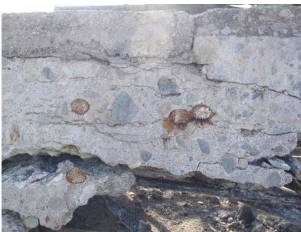
図-付 1.6 事例 1, 床版切断面の水平ひび割れ
