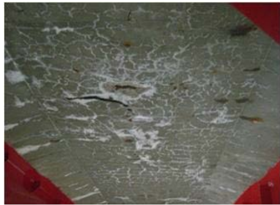
図-付 1.23 事例 4, P7-P8, G1-G2, ひび割れ・石灰分
