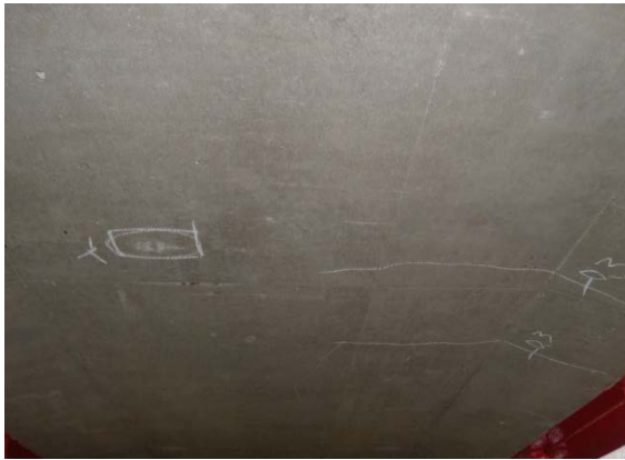
図-付 1.22 事例 4, P7-P8, G3-G4, ひび割れ・石灰分
