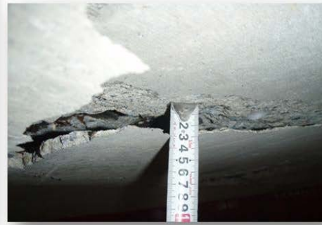
図-付 1.19 事例 4, 床版下面のかぶり不足と鉄筋腐食
