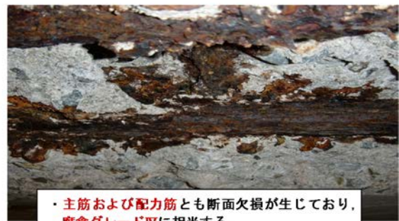
図-付 1.24 事例 4, 床版下面の鉄筋腐食
