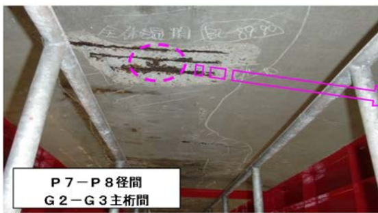
図-付 1.24 事例 4, 床版下面の鉄筋腐食
