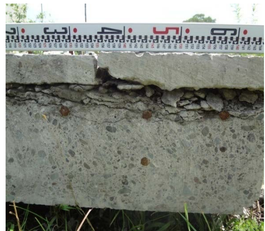
図-付 1.14 事例 2, 床版はつり面及び切断面で見られたコンクリートの砂利化
