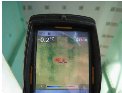
写真-2 赤外線サーモグラフィ
