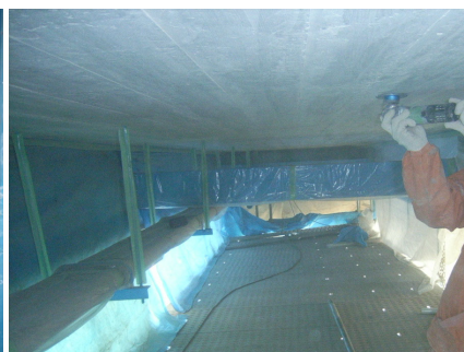
写真-9 施工前の型枠痕除去
