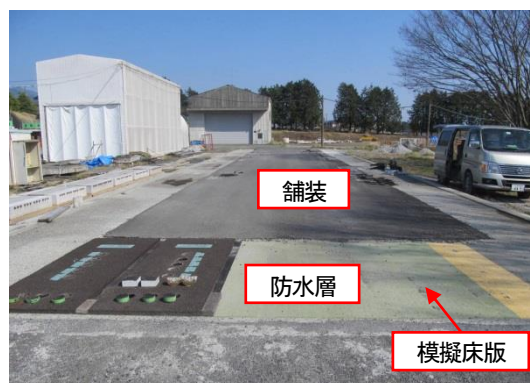
写真-3 模擬床版の試験ヤード
