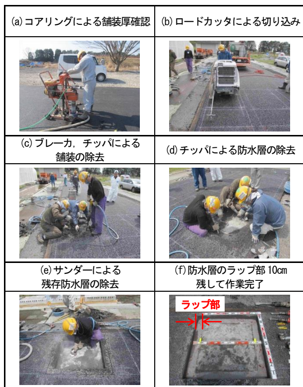
写真-1 従来方法による舗装～防水層の除去例
