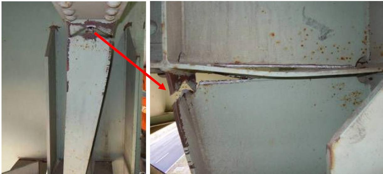
写真-2.11 垂直補剛材の損傷状況<sup>2.4)</sup>
