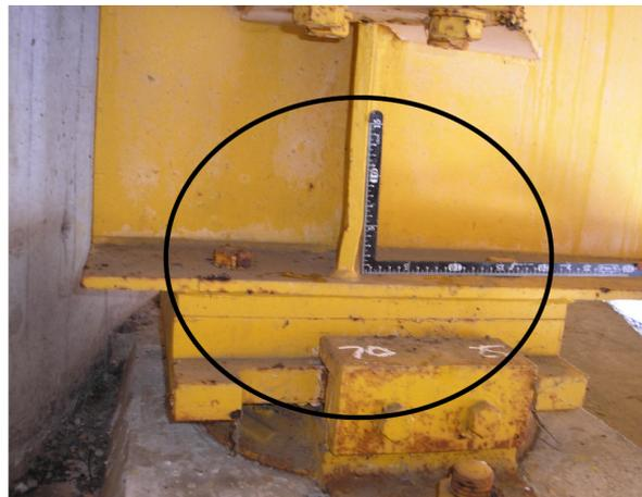
写真-2.7 垂直補剛材の局部変形<sup>2.4)</sup>
