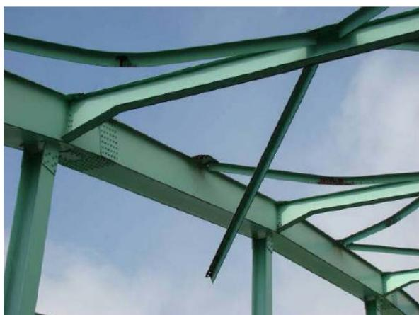
写真-2.8 アーチ橋における横構の座屈およびガゼットの破断<sup>2.4)</sup>
