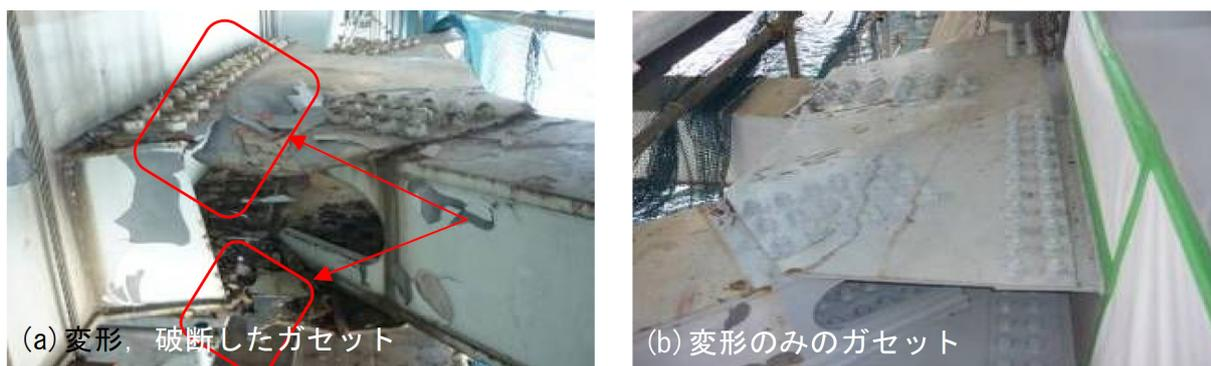
写真-2.12 ガセットの損傷状況<sup>2.4)</sup>
