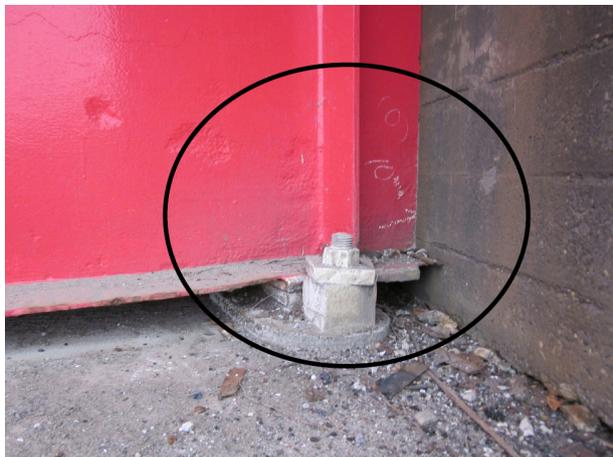
写真-2.6 主桁下フランジの局部変形<sup>2.4)</sup>
