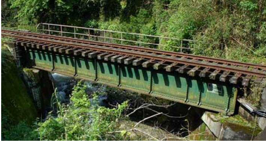
鋼桁(上路プレートガーダー)
