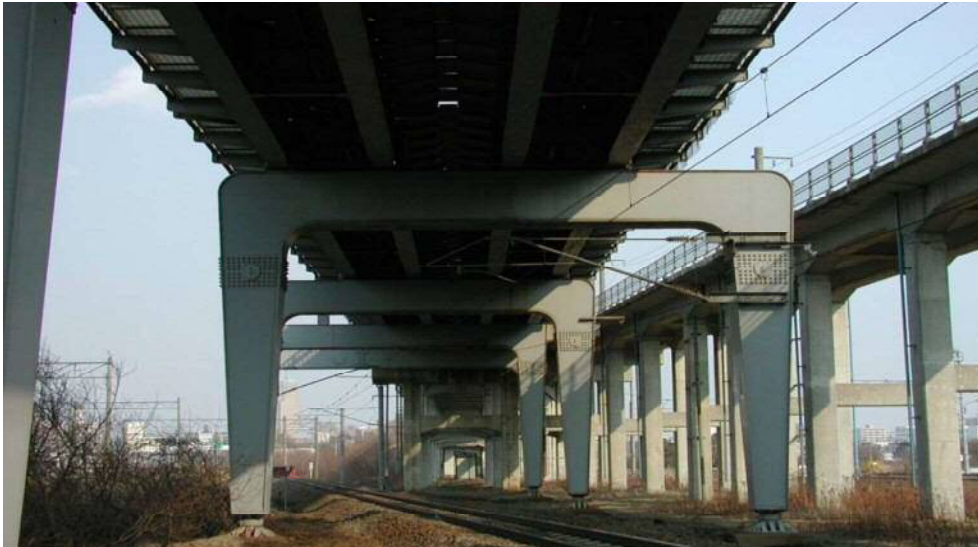
鋼ラーメン橋脚
