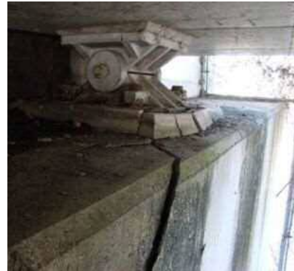
支承部で本体側が大きく損傷した例
