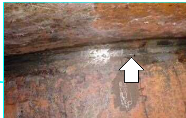
鋼製橋脚(円柱)隅角部の継手部
