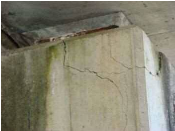
検査路等がなく近接できない例
