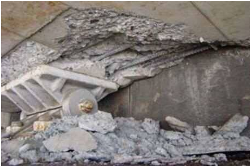
支承部で本体側が大きく損傷した例
