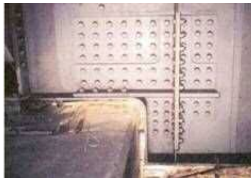
桁切欠き部の補強
