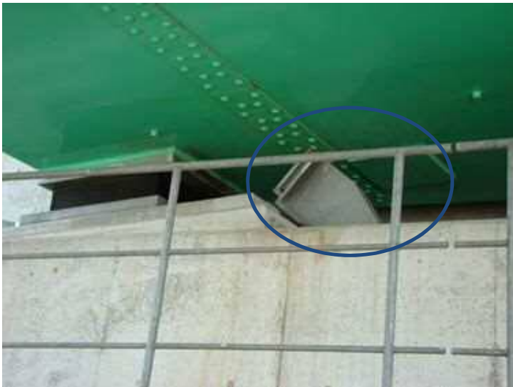
第三者被害が懸念される破壊形態となった例
