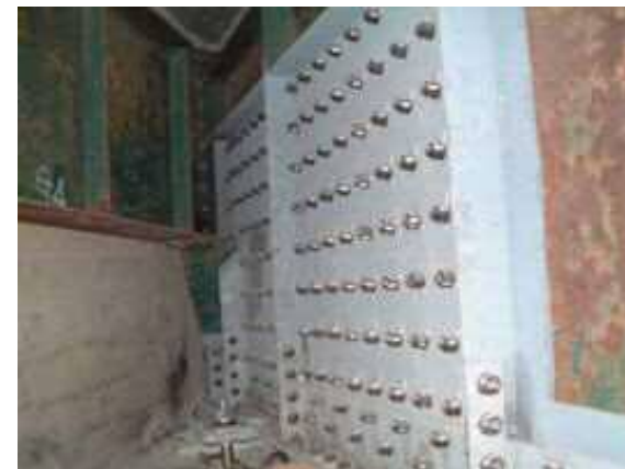
桁端部の補強
