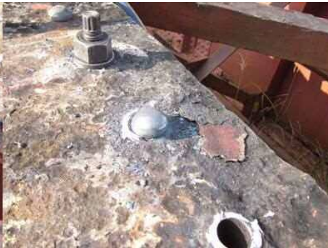
締められたリベット
