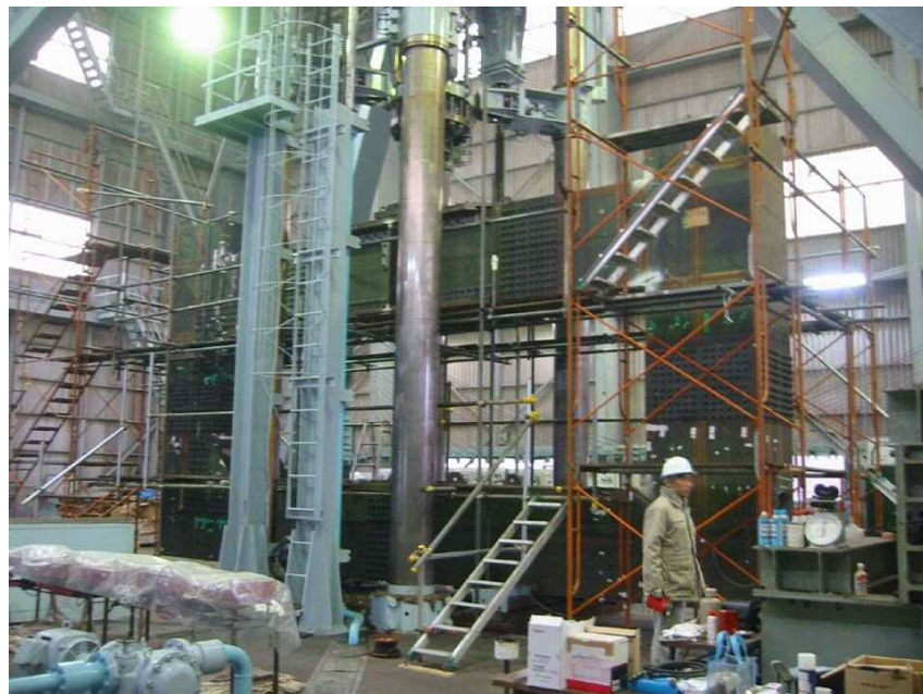
鋼製橋脚(首都高)
