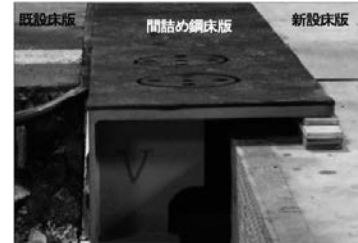
写真-3.3.3 間詰め床版設置状況 1)
