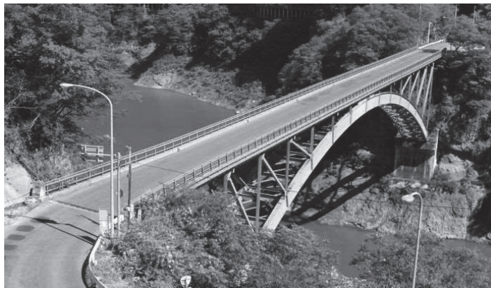
写真-3.8.1 大規模工事後の状況 1)
