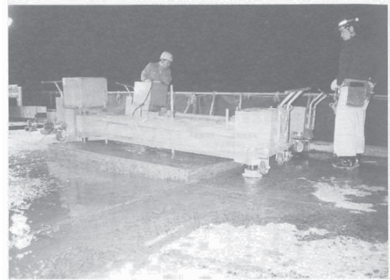
写真-3.8.3 ジャッキを用いた工法によるRC床版撤去状況 3)
