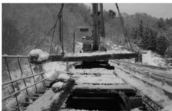
写真-3.4.1 既設 RC 床版撤去 1)
