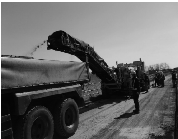
写真-3.1.2 大型路面切削機
