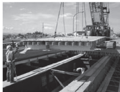
写真-3.5.5 鋼床版架設状況 1)
