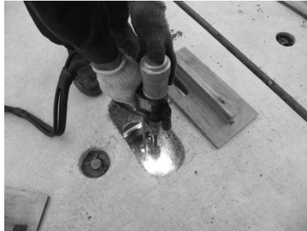
写真-3.1.4 スタッドの施工
