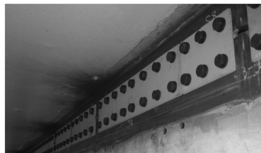
写真-3.3.5 主桁ウェブ仮添接 1)
