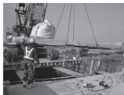
写真-3.5.3 RC床版撤去状況 1)
