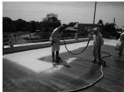
写真-3.1.5 ウレタン吹付け
