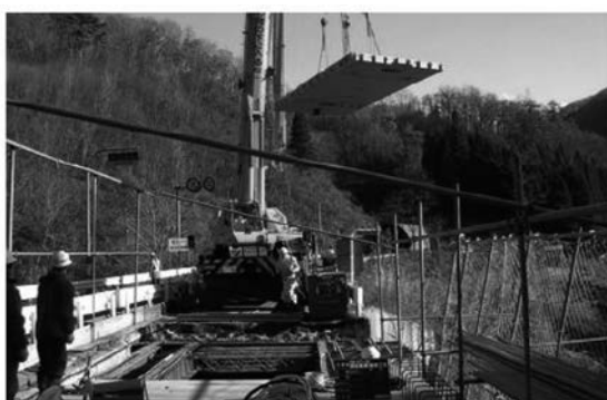
写真-3.4.2 プレキャスト PC 床版架設 1)
