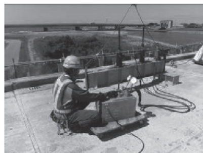
写真-3.5.2 ジャッキアップ状況 1)
