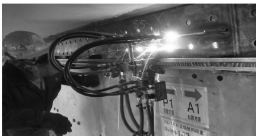
写真-3.3.4 主桁ウェブ切断 1)
