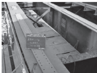
写真-3.5.4 既設上フランジ穿孔及びワイアプレート設置状況 1)
