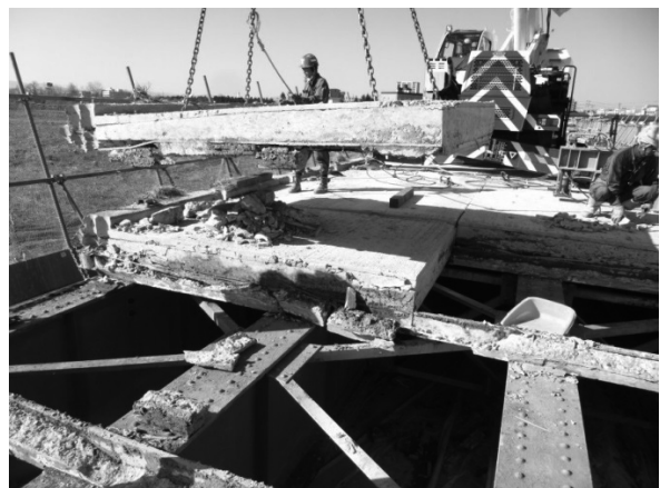
写真-3.1.3 床版撤去状況
