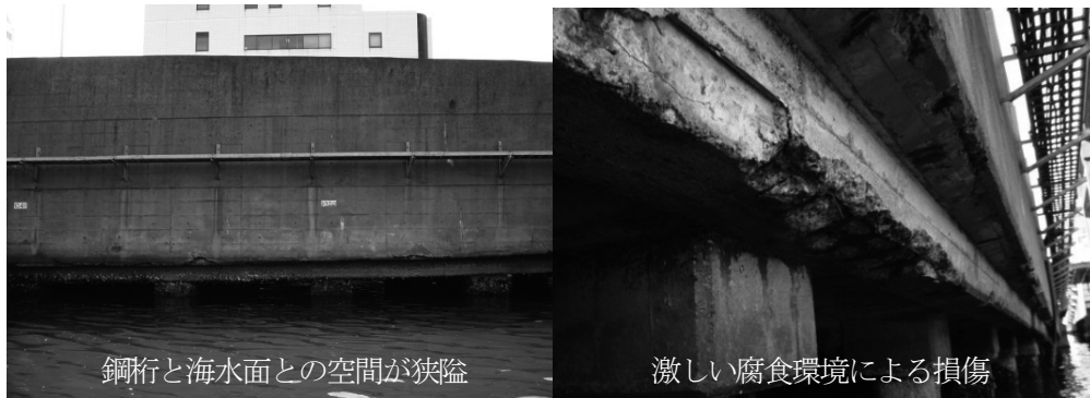
写真-1.3.2 東品川栈橋部の状況
