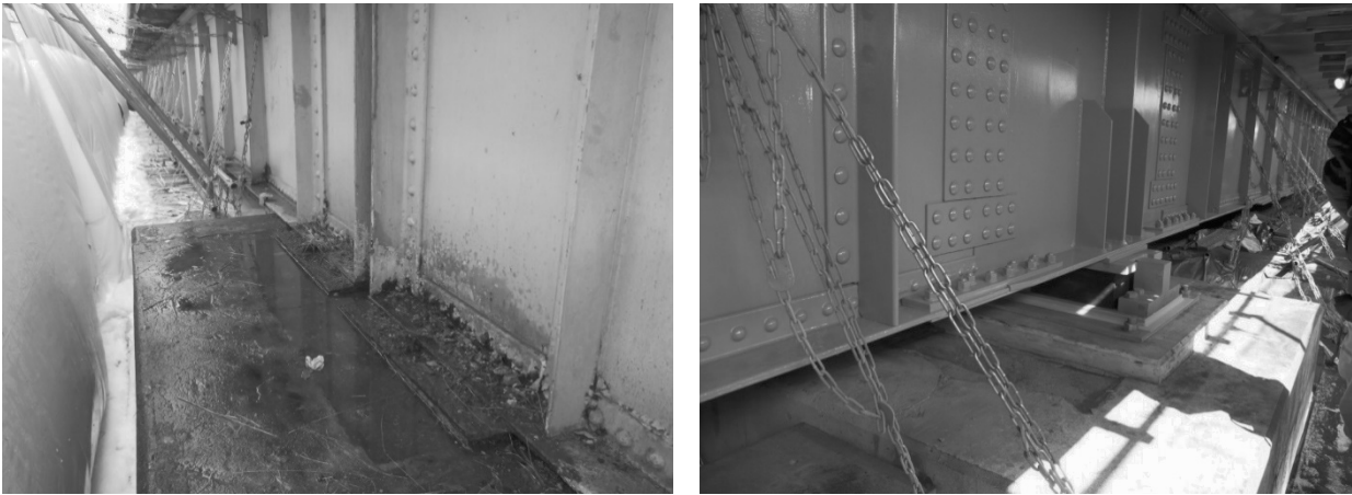
(1) 桁端部取替前
