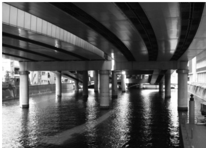
写真-1.3.9 桁下の状況
