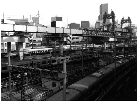
写真-1.3.12 東北縦貫線建設工事 桁架設機全景 6)
