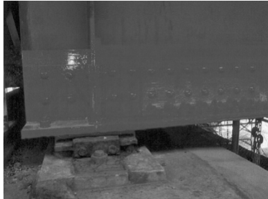
写真-1.4.8 腐食部の当板補強 ③ (写真-1.4.1の補強事例)
