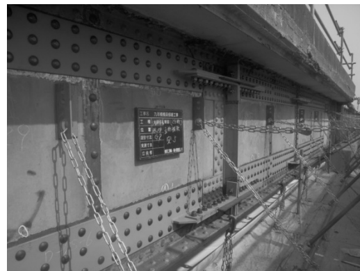
(2) 当て板による補強
