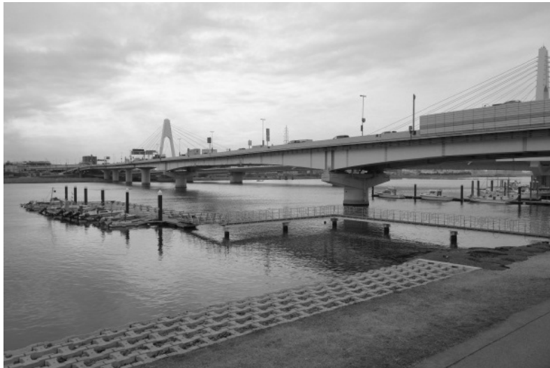
写真-1.3.4 高速大師橋の全景
