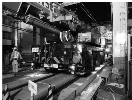
図-12 RC 製線路覆工板と 100t クレーンの移動
