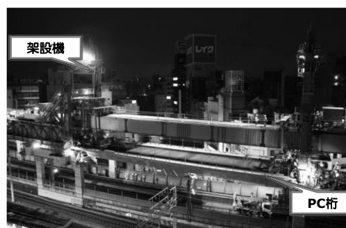
(c) PC 桁架設状況
