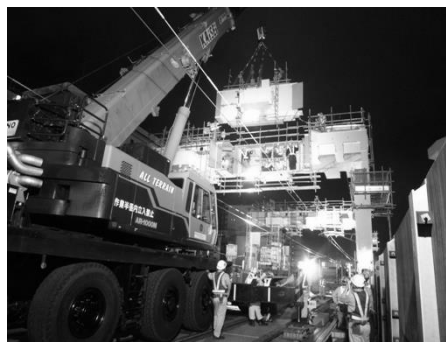
図-13 100t クレーンによる鉄骨部材架設
