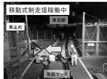
図－10 作業ヤードの状況と工事用運搬台車
