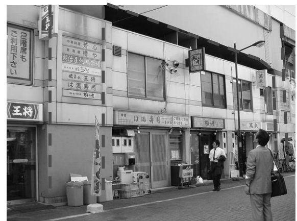
図－４ 高架橋下部状況（－ － － 部が高架橋）
