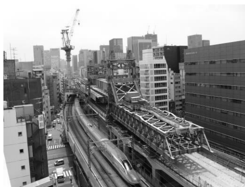
(b) 移動式架設機全景
