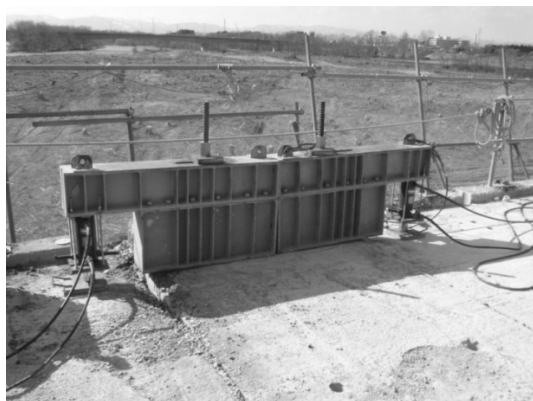
図-3 床版はく離 3)
