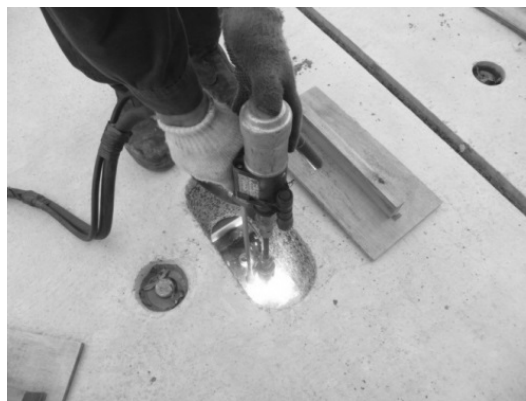
図-4 スタッドの施工 3)
