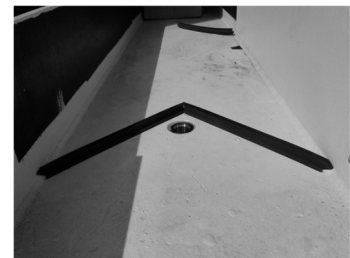
写真-5 排水設備追加
