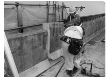
写真-3 壁高欄撤去
