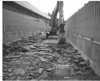
写真-2 舗装撤去
