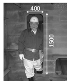
(b)マンホールの通過状況
