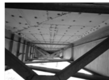
図-9 下鋼板補強
