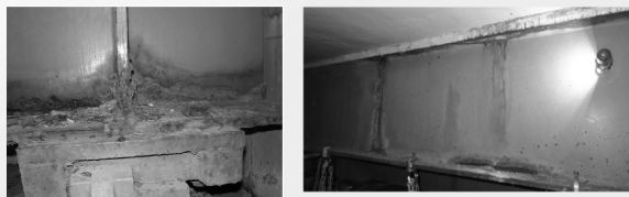
床版ひび割れ部からの漏水による腐食 (補強桁)
