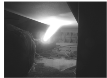
図-18 狭隙部の溶射状況
