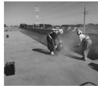
図-5 床版防水層の設置
