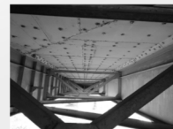
床版増厚補強
