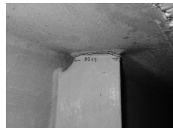
図-20 垂直補剛材上端溶接部
