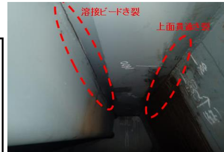
ビードき裂と貫通き裂(桁内)
