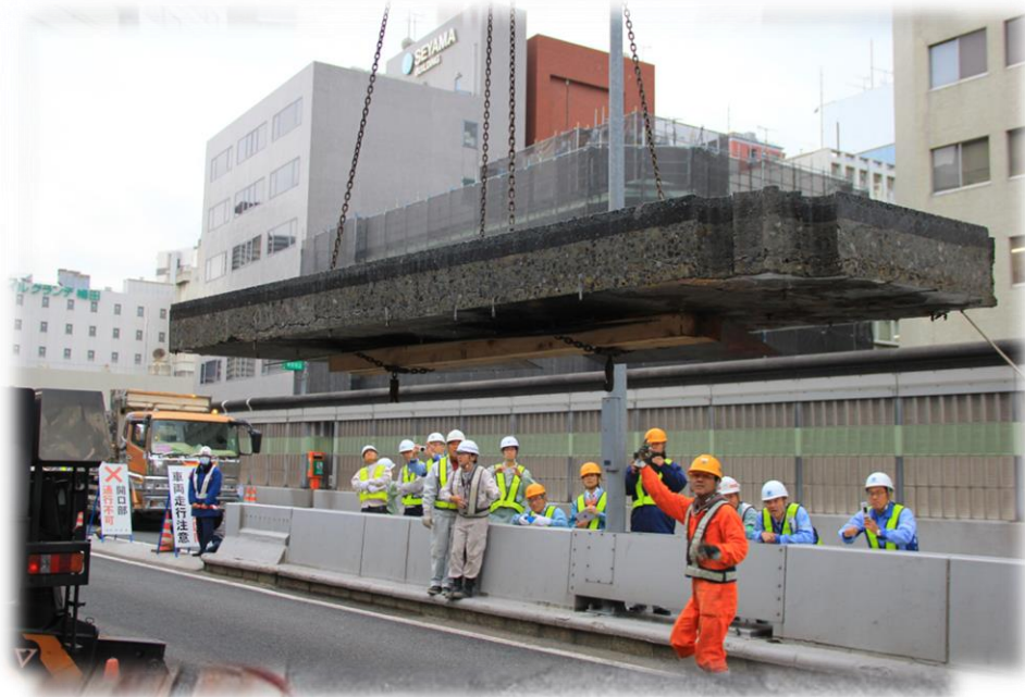
実橋からの切り出し
