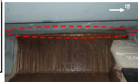
貫通き裂と漏水(桁内)
