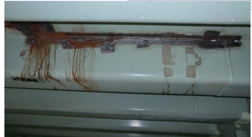
鋼床版のデッキプレートとUリブ溶接部のき裂
