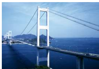
来島海峡大橋 (1999年完成)
