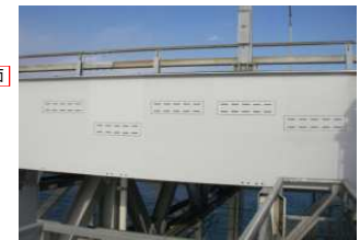
定点設置作状況
