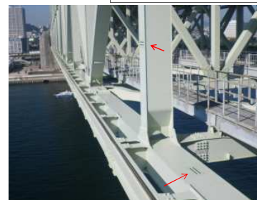
塗膜消耗計測用定点の増設
