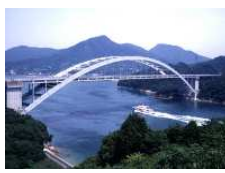
大三島橋 (1979年完成)
