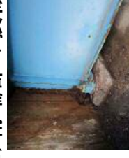
桁端腐食
