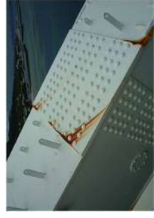
小型材片・鋼板こぼれ腐食状況
