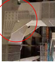
鋼製橋脚隅角部当て板補強
