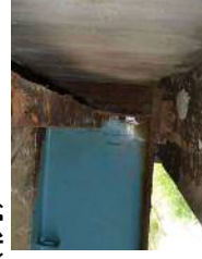
端横桁腐食
