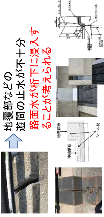
伸縮装置と一体型の地覆部止水例
