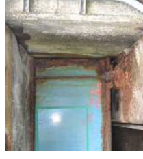
桁端腐食
