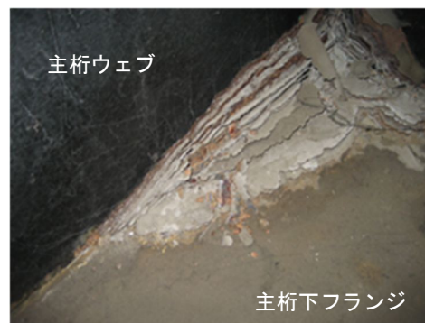
写真 4.7 内面における錆の層状剥離
