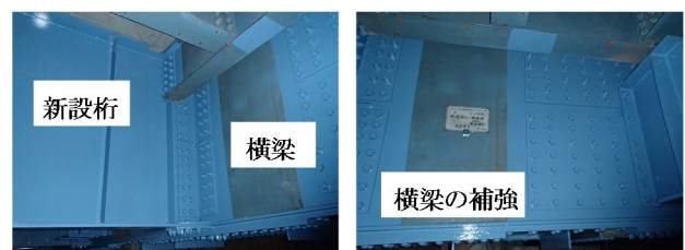
図 4.6 ゲルバー桁の連続化
