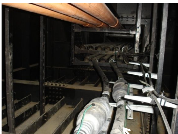
写真 3.3 実際の箱桁の内状況
