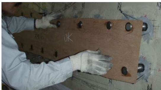
写真 3.1 アンカーボルト位置計測状況
