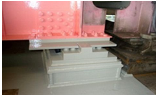
写真 4.8 当て板補強の施工事例
