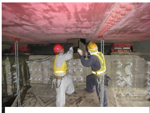
写真 3.5 マンホールからの取込
