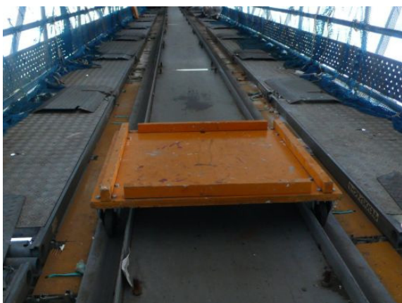
写真 3.6 作業足場上で運搬台車設備
