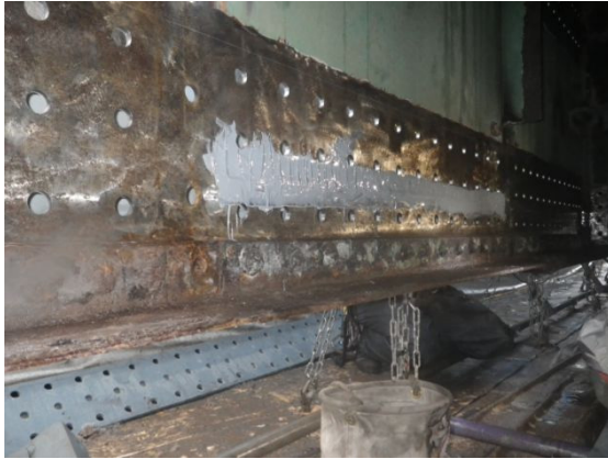
写真 3.8 腐食欠損部の不陸修正 (エポキシ樹脂パテ)
