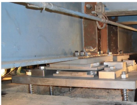
写真 4.2 支承取替 (支承モルタル施工前)
