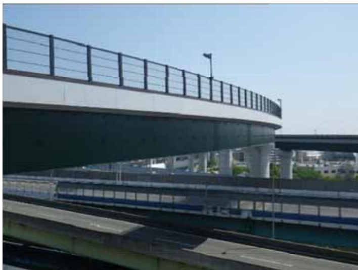
金属溶射橋梁の例 (近畿自動車道 門真JCT橋; 平成22年)
