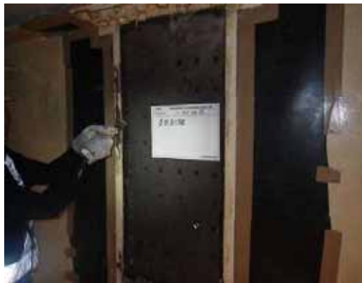
施工面の養生例
