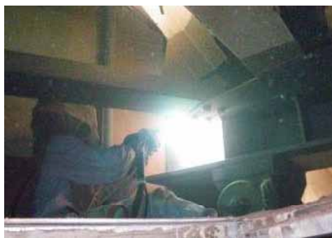
プラズマ溶射機 (TAPS) による 桁端溶射の例
