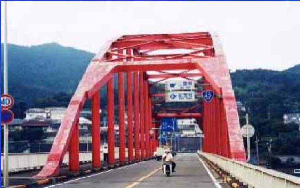
ア一子橋全景 (施工前)
