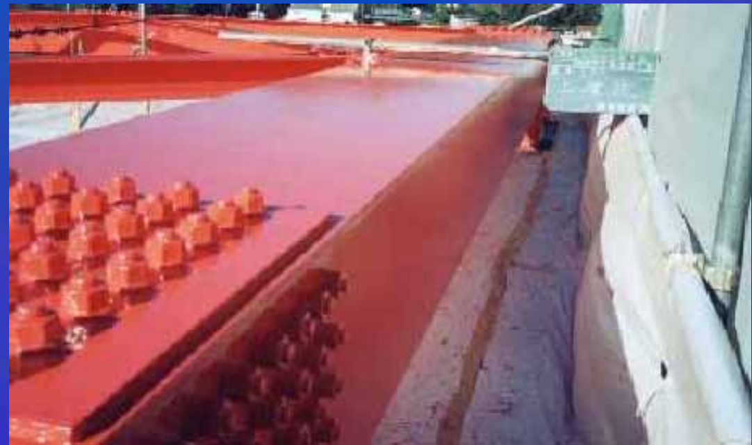
アーチ橋接写 (施工完了)
