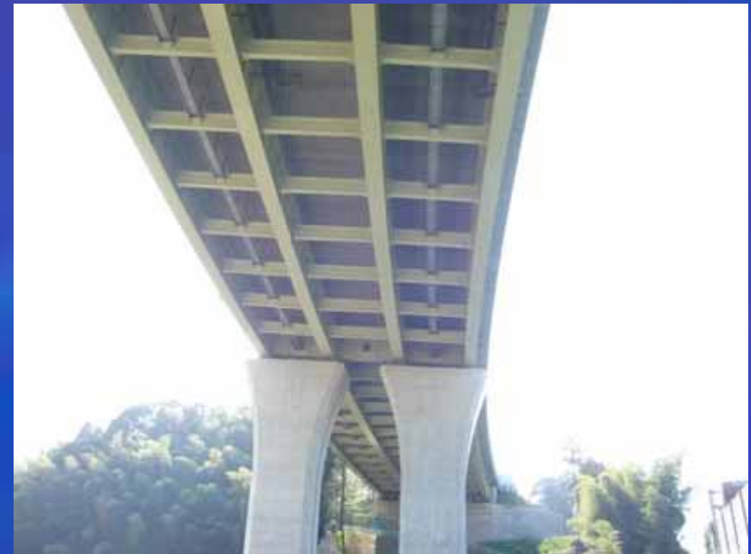
木下高架橋(合成床版)
