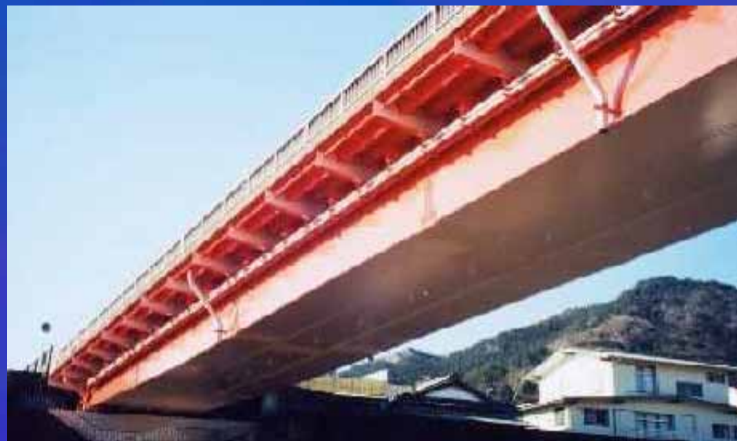
箱桁全景 (施工完了)
