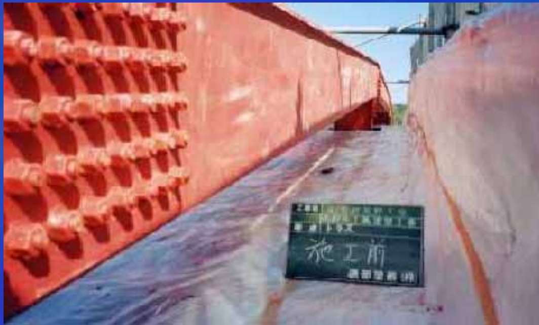
アーチ橋接写 (施工前)
