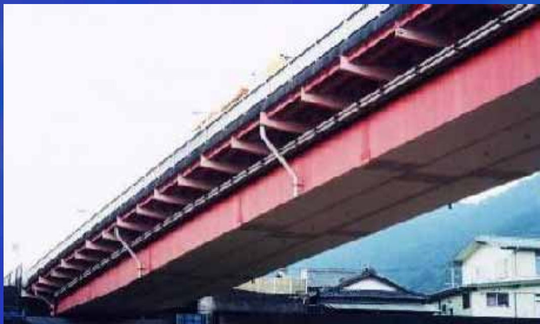
箱桁全景 (施工前)
