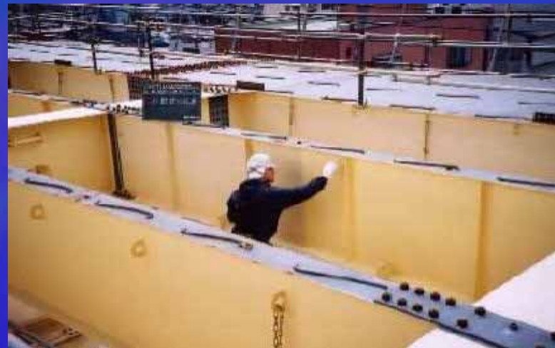
縦桁Web (施工中)
