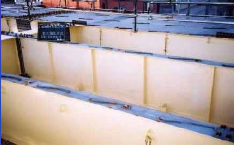
縦桁Web (施工前)
