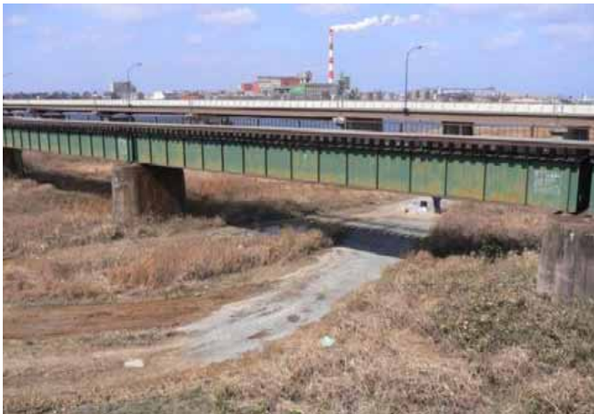
鋼橋(防食性がメイン)
