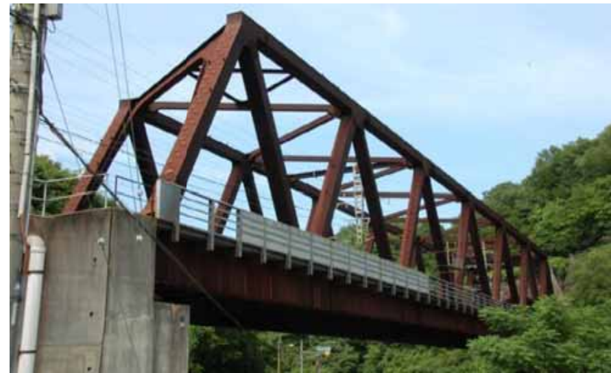
無塗装橋梁の例
