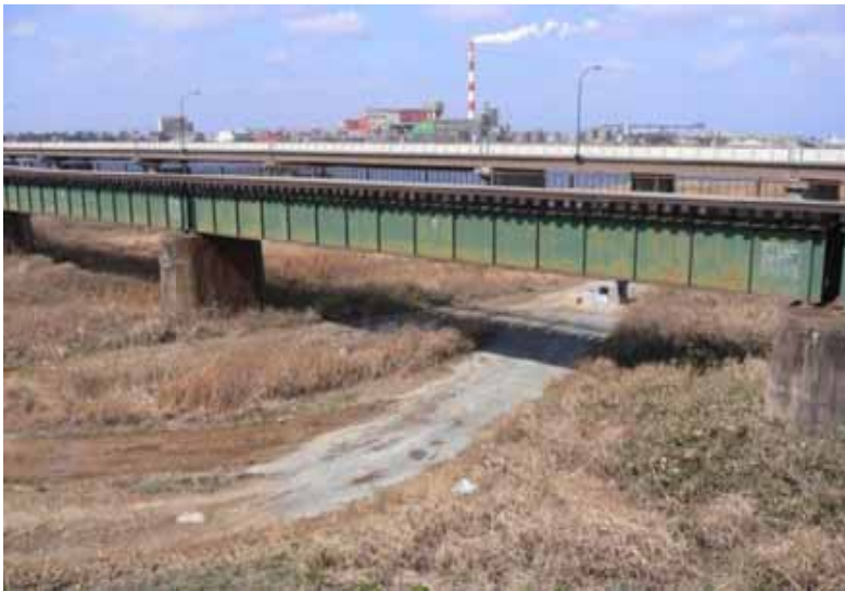
塗装橋梁の例
