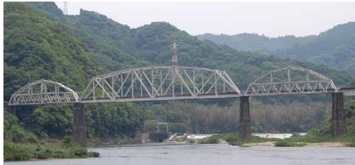
JR関西本線 木津川橋梁 1907年～(100年以上供用) ※1, 3連目
