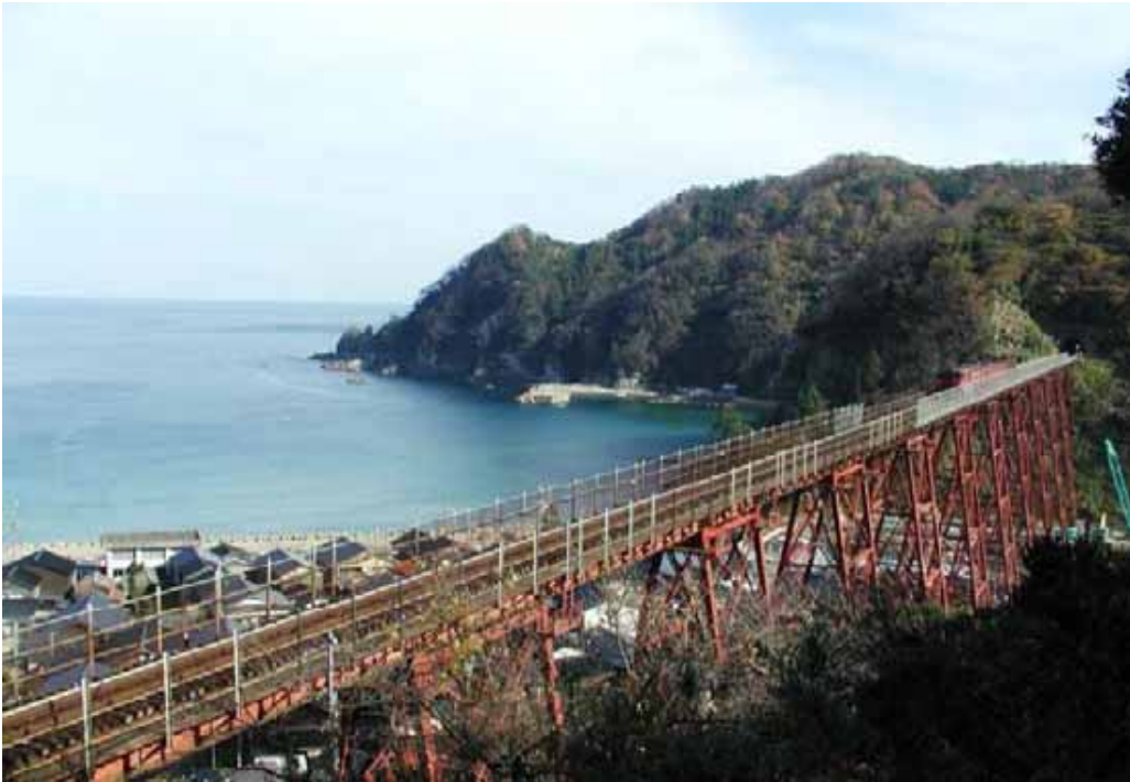
JR山陰本線 余部橋梁 1912年～2010年(約100年間供用)
